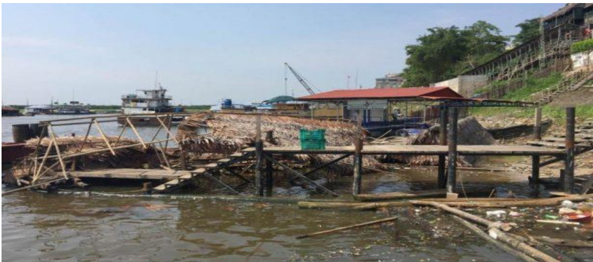
Figura 1. Viviendas colapsadas por los vientos fuertes y humedad.
