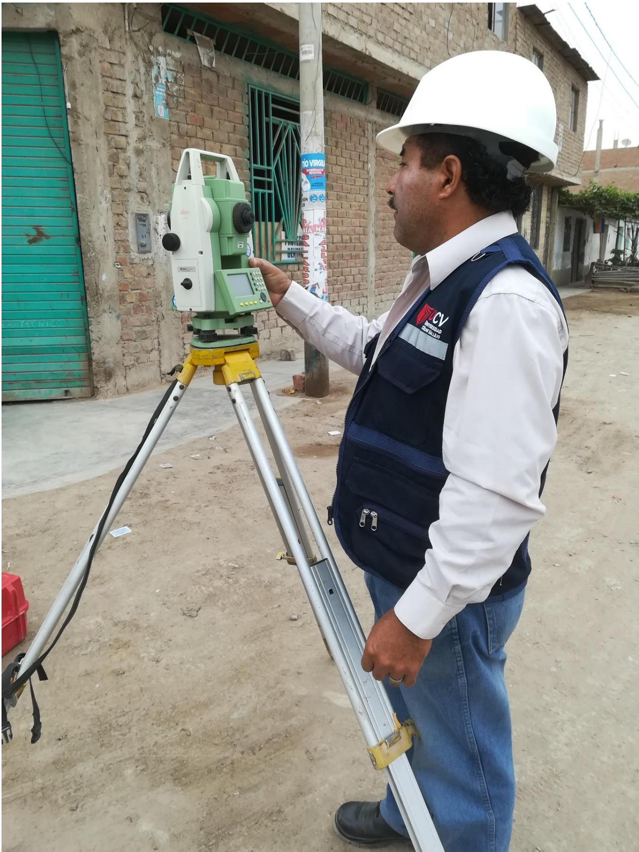
Aplicando procedimiento como estación libre y estación por coordenadas con un punto fijo
