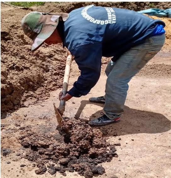
*Figura N° 07: Mezcla de CPT con la masa de arcilla.*
