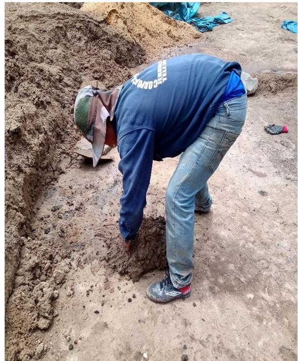
Fotos N° 03: Combinado la ceniza de paja de trigo con la masa de arcilla.
