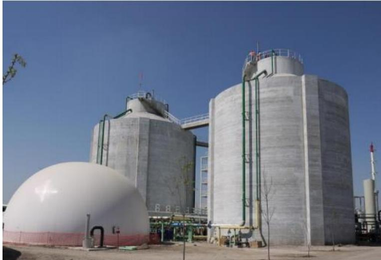
**Figura 6.** *Digestores anaerobios y almacenamiento de biogás*
