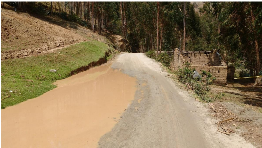
Figura 2. Carretera no pavimentada ruta Talavera - Huancaray
