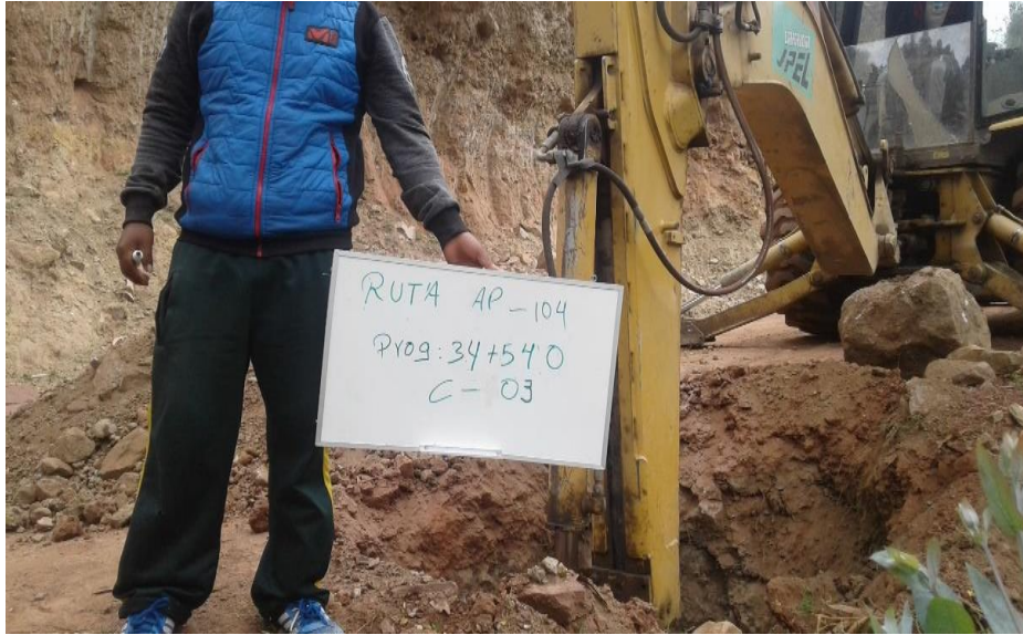
Fotografía 5. Calicata 3 Prog. Km 34 + 540 - Huancaray
