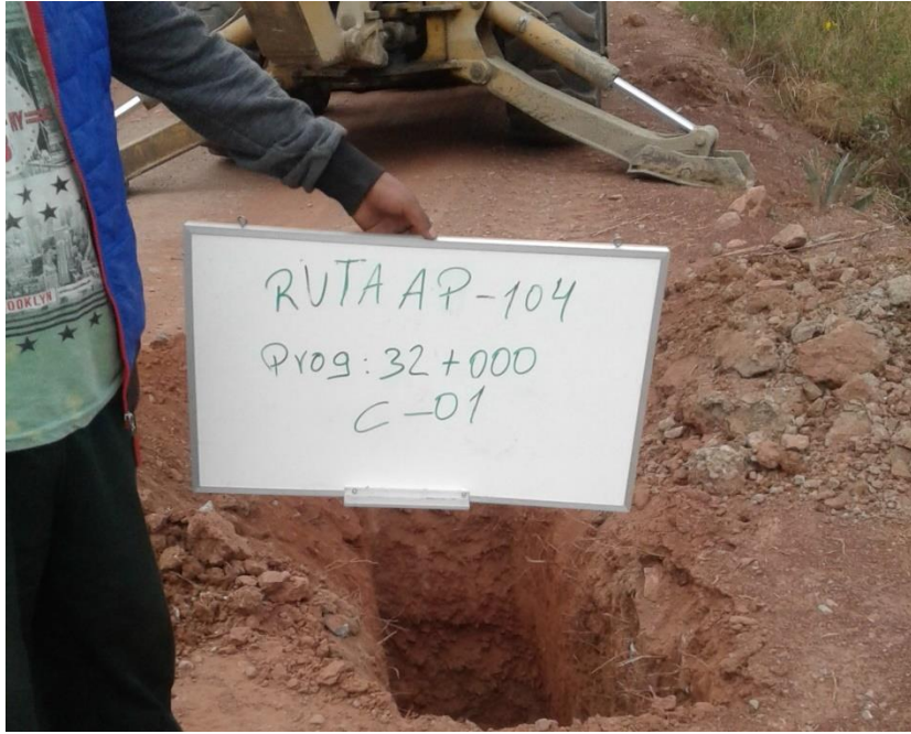
Fotografía 3. Calicata 1 Prog. Km 32 + 000 - Huancaray
