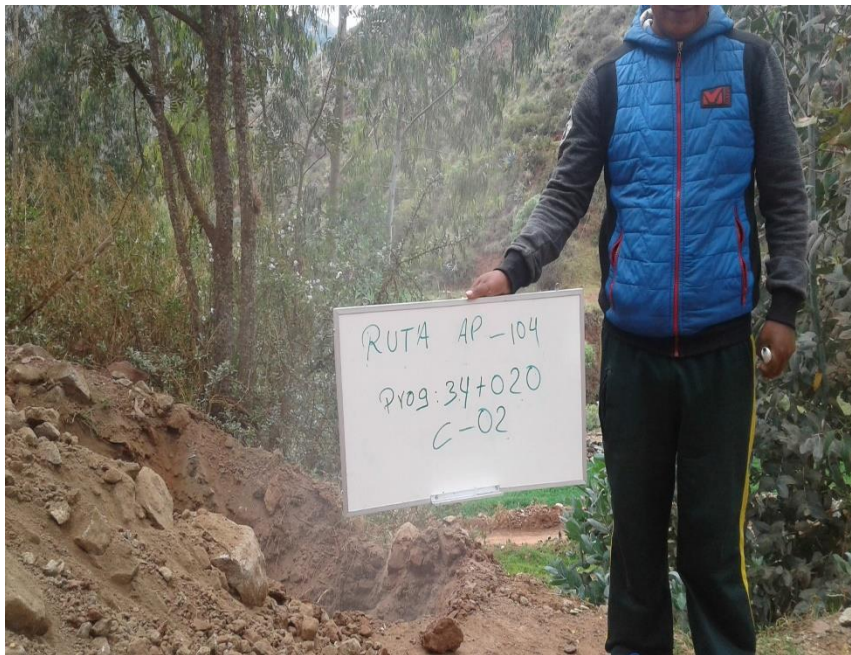
Fotografía 4. Calicata 2 Prog. Km 34 + 020 - Huancaray
