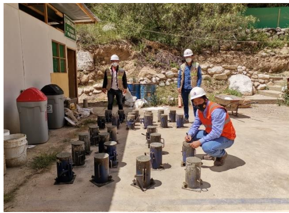
Elaboración de Briquetas de concreto
