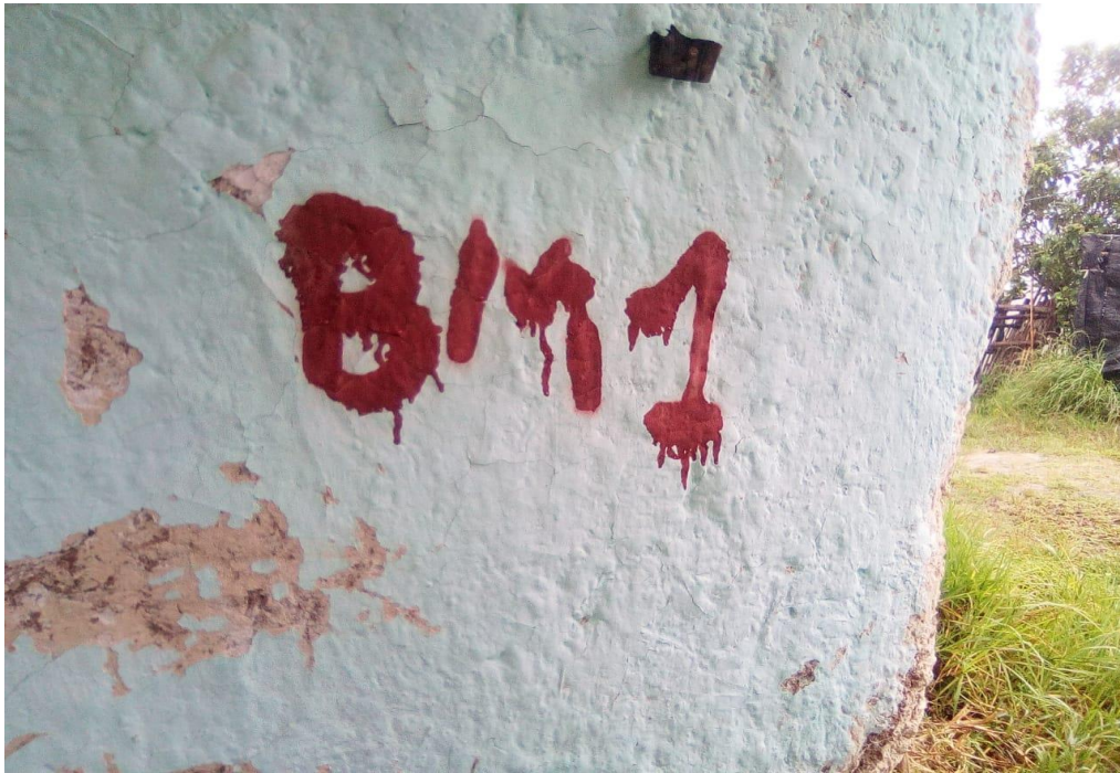
Figura 03: Señalización de BMs.
