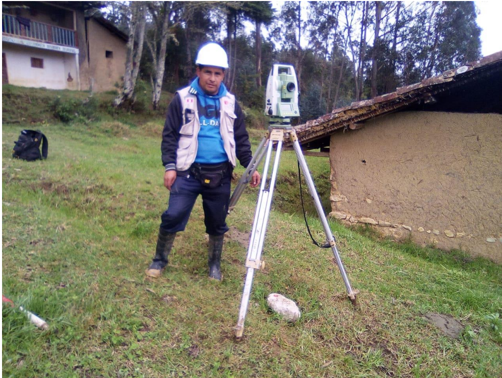
Figura 01: Posicionamiento de estación en progresiva 0+000.
