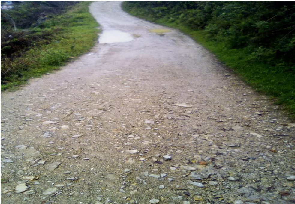
Figura 02: Continuación del levantamiento topográfico de carretera.
