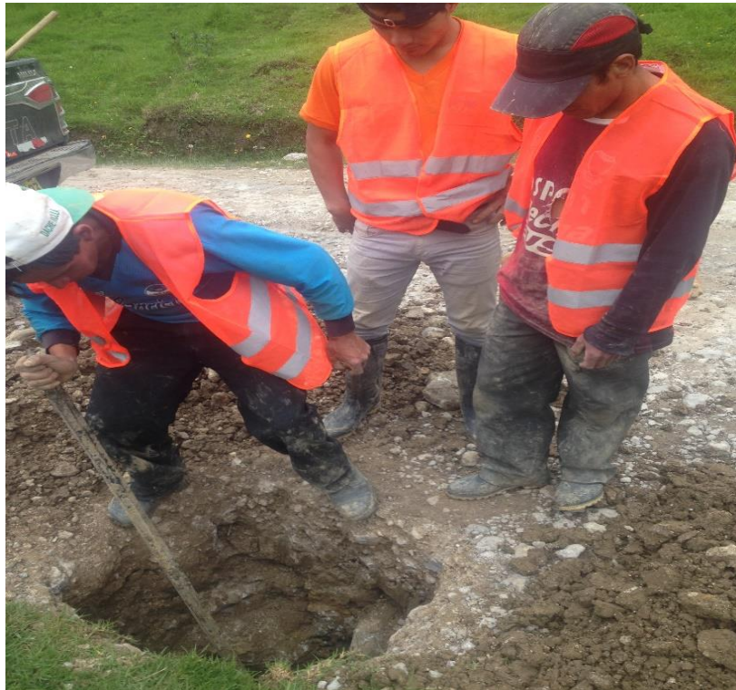
Excavación de calicatas a cielo abierto
