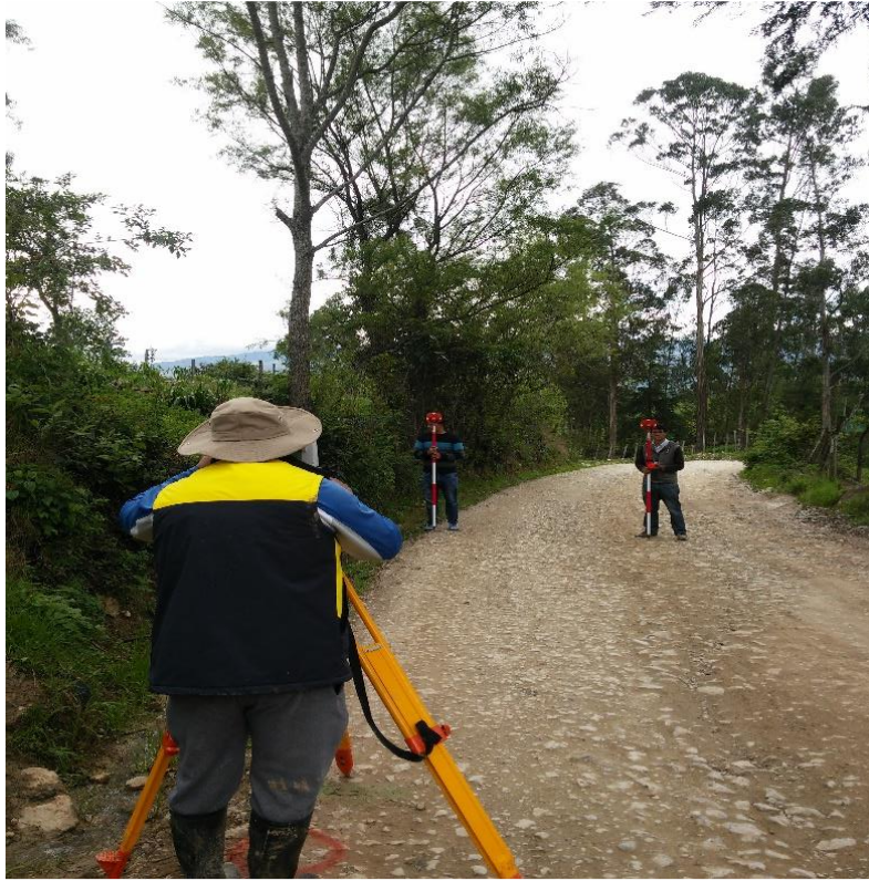
Levantamiento Topográfico con Estación total
