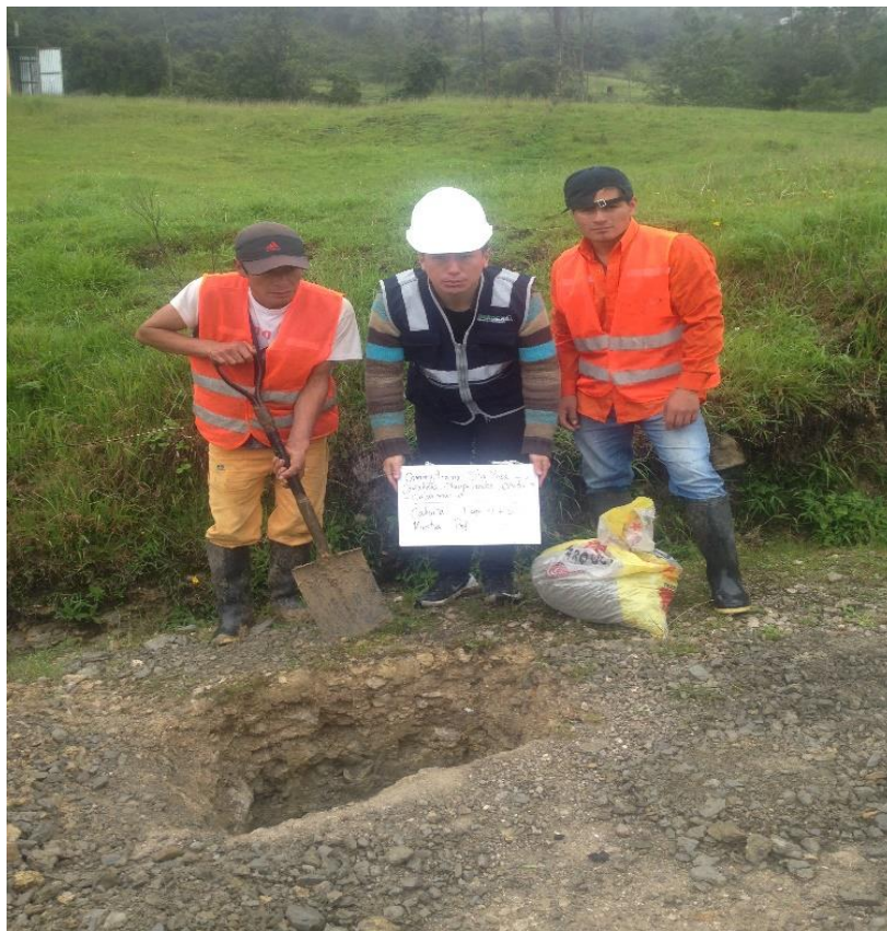
Extracción de muestras para ensayos LL, LP y CBR
