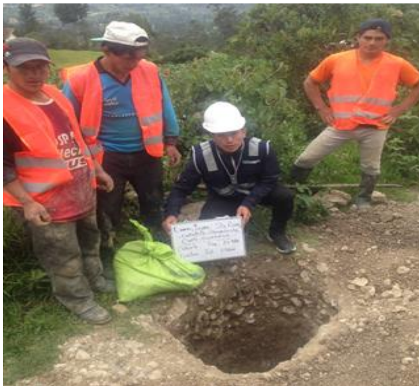
Fuente: Elaboración Propia Muestra obtenida de Calicata N°2 Ubicada en Km 0+600
