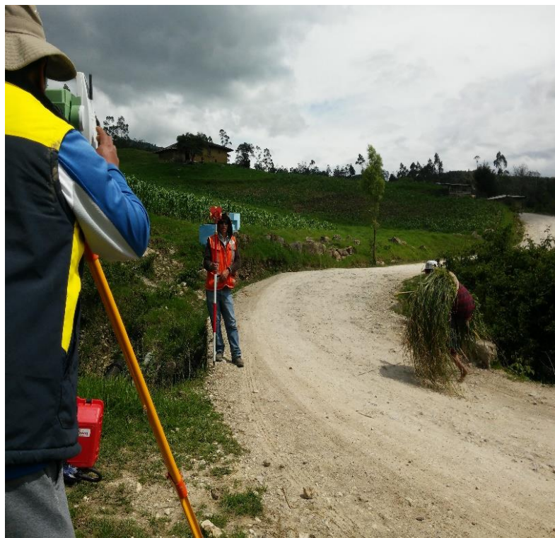
Levantamiento Topográfico en curvas cerradas
