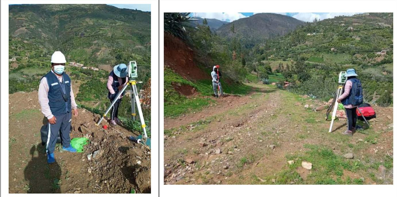
Figura 18: Levantamiento topográfico carreta Primorpampa - Cascapara
