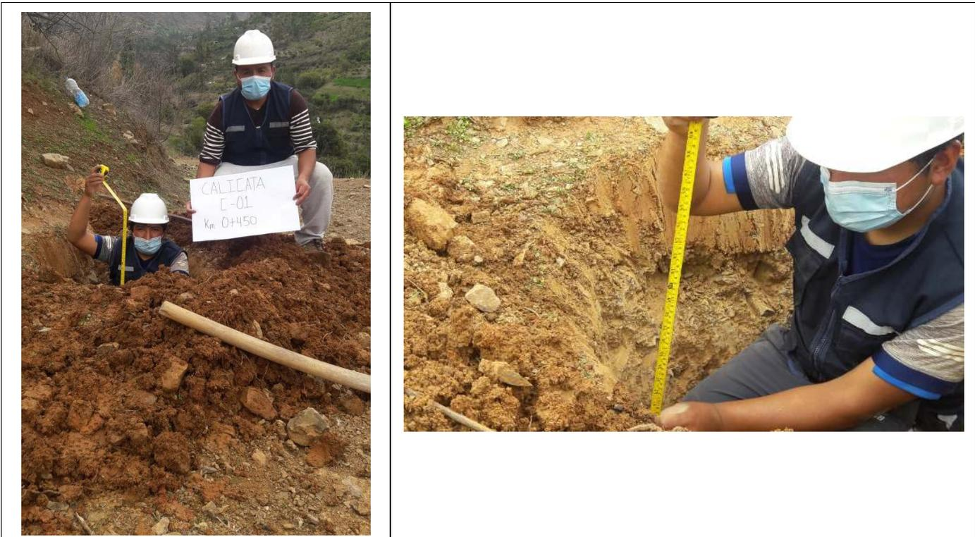
Figura 19: Excavación de calicata en el tramo a intervenir.
