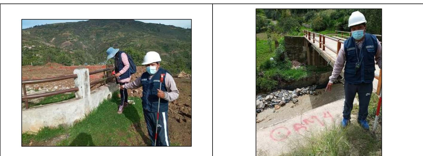
Figura 17: Determinación de BM's en la carreta Primorpampa - Cascapara
