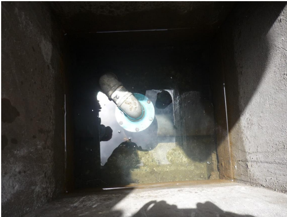
FOTOGRAFÍA N°03: Válvula de aire en mal estado a una altura de 0.50m del terreno
