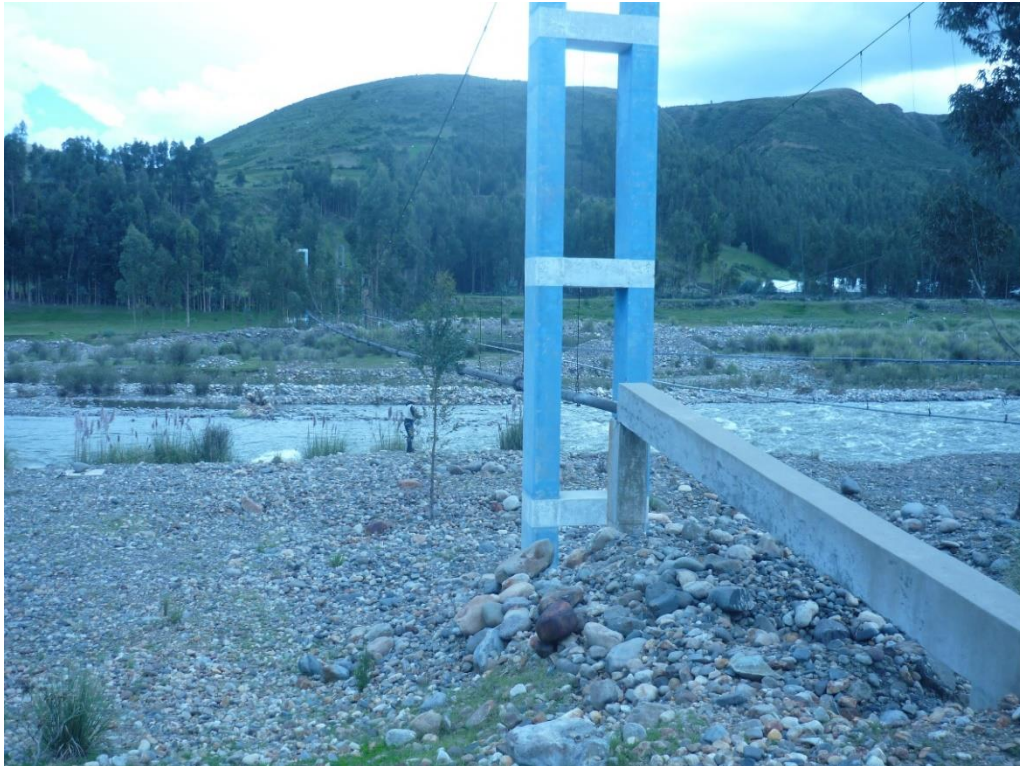
FOTOGRAFÍA N°15: Trasvase con una longitud 160.0m
