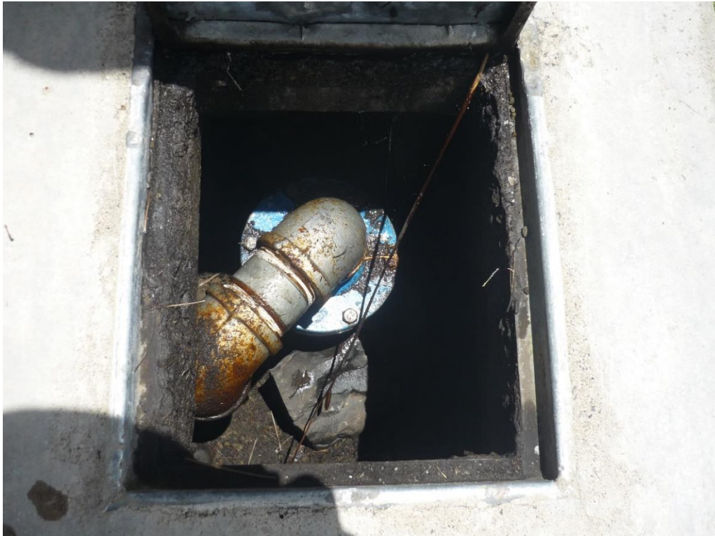
FOTOGRAFÍA N°07: Válvula de Purga en mal estado altura de 0.50m del terreno
