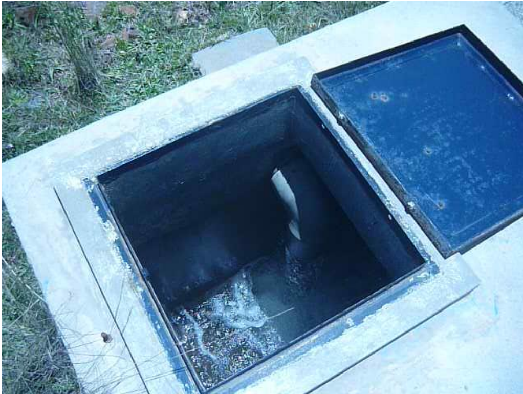
FOTOGRAFÍA N°13: CRP6-04 se midió el caudal encontrándose un caudal de 6lt/S
