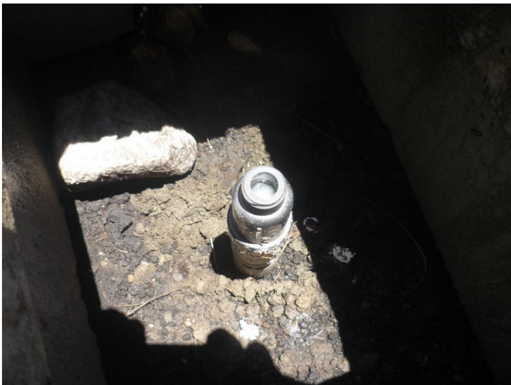
FOTOGRAFÍA N°07: Válvula de Purga en mal estado altura de 0.50m del terreno
