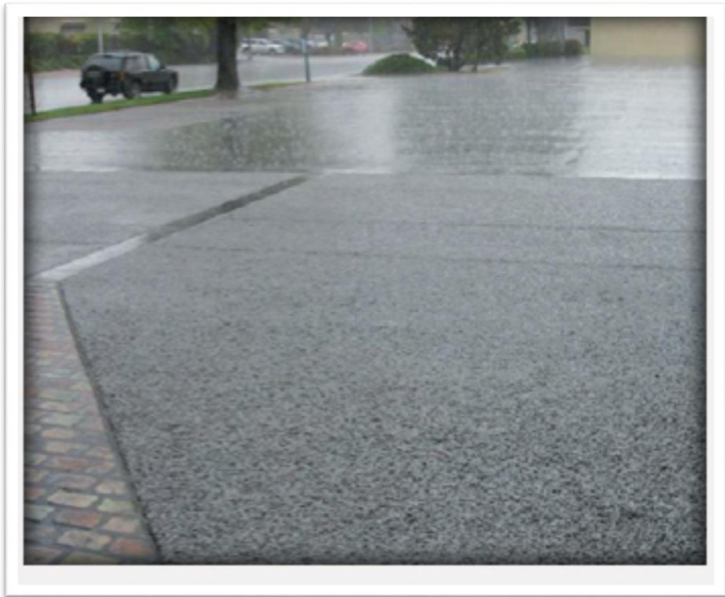
Figura 1 concreto permeable de la ciudad de México
