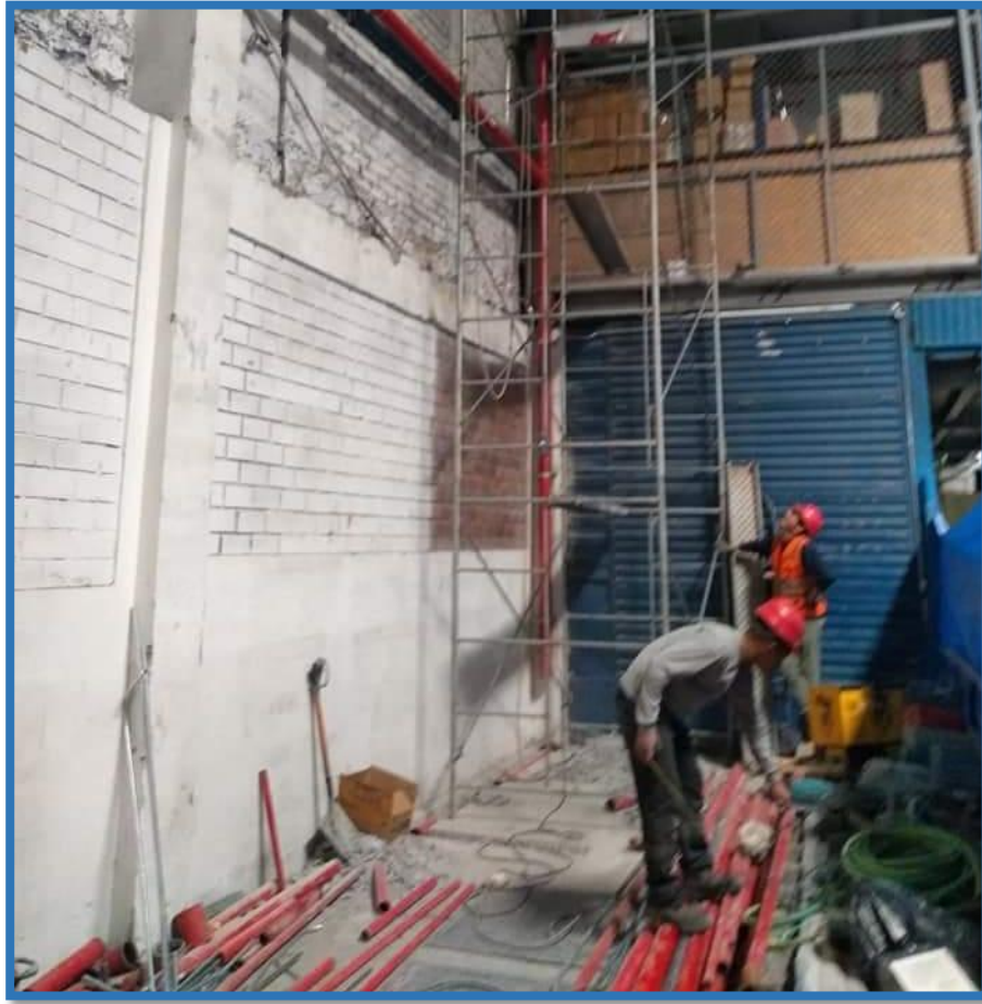
Figura 11 : Técnicos realizando una Instalación de tuberías Contra incendios.
