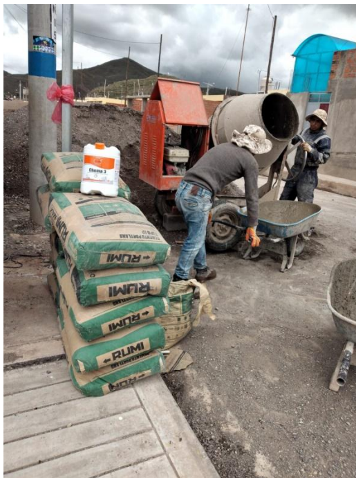
Fotografía N°1 : Se visualiza los materiales con los que se realizaran las briquetas
