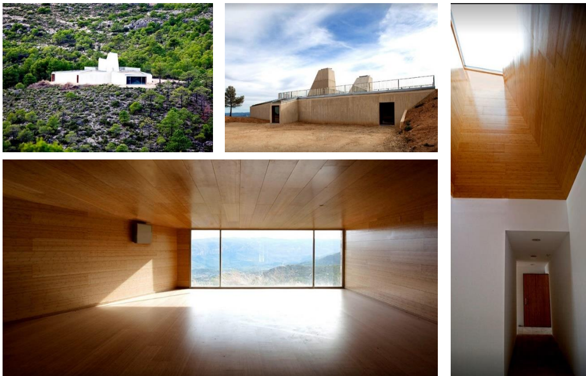
Figura 19: Vista exterior e interior del centro de interpretación del parque natural los calares del mundo y de la sima
