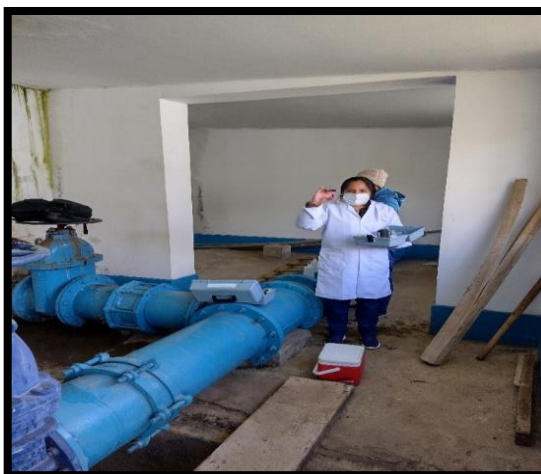
Figura 25. Uso de 1.5 mg (DPD) en el frasco con la muestra y lectura de cloro residual en el reservorio.
