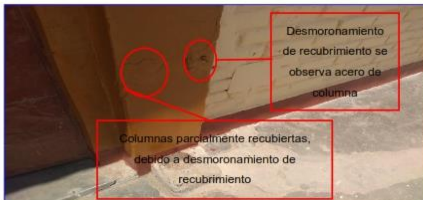
Imagen 10: Columnas parcialmente recubiertas durante el mantenimiento
