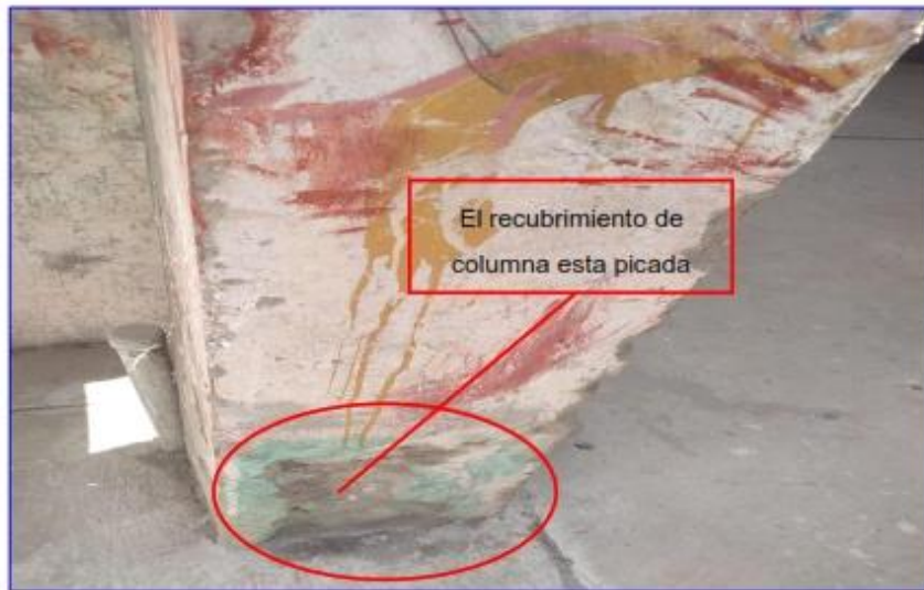
Imagen 56: Picado de recubrimiento de columna.
