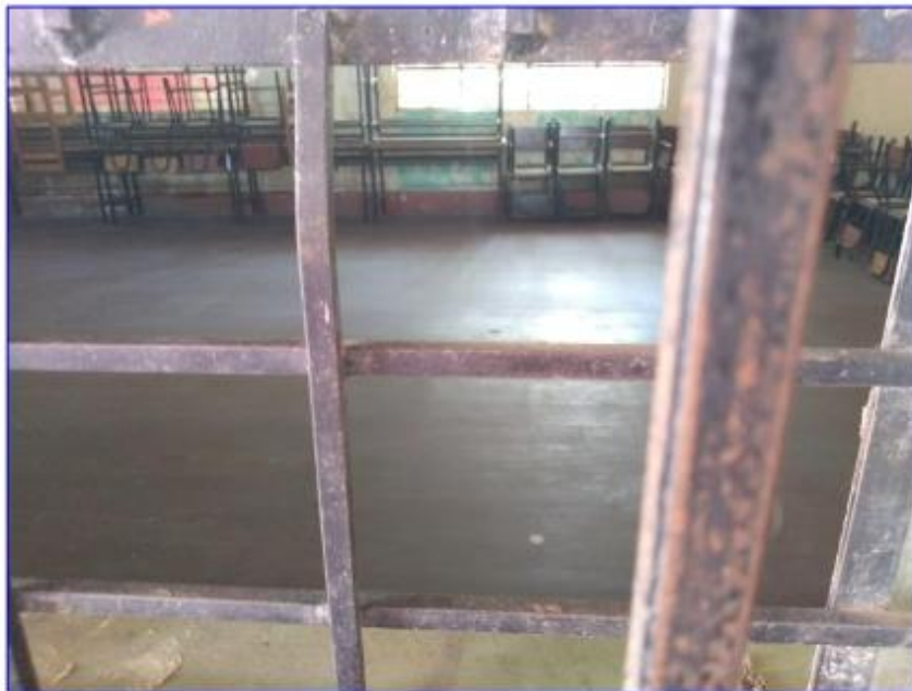
Imagen 28: Piso interior de cemento pulido.
