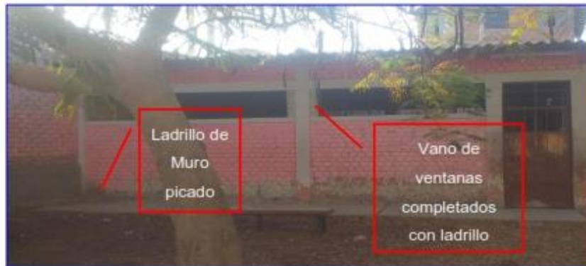
Imagen 8: Aula N°12 antes del mantenimiento
