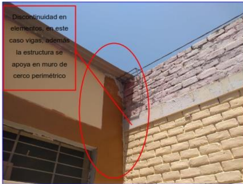
Imagen 50: Discontinuidad en elementos.
