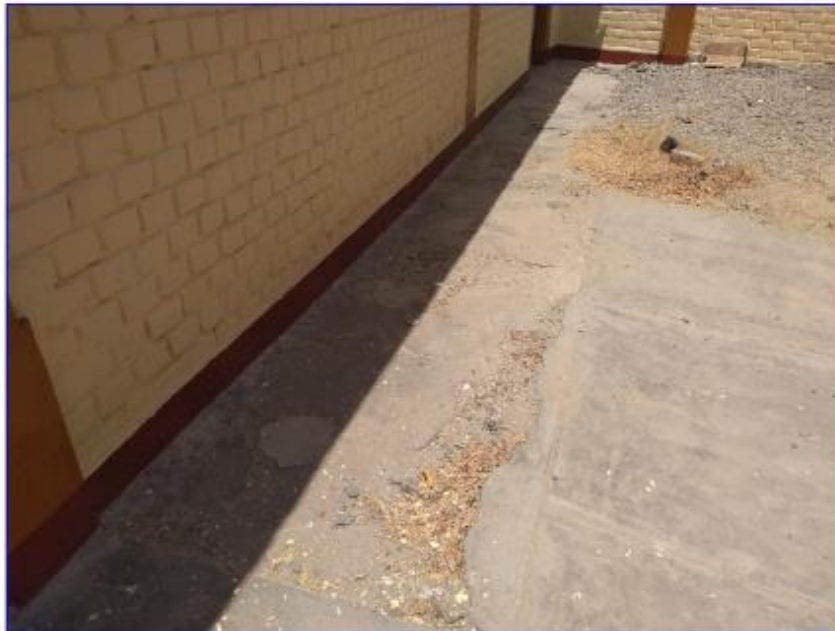
Imagen 71: Veredas agrietadas.
