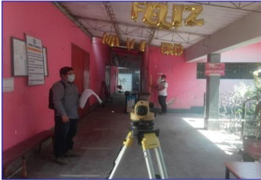
Imagen 12: Ubicación de puntos en ambientes existentes - Pabellón C
