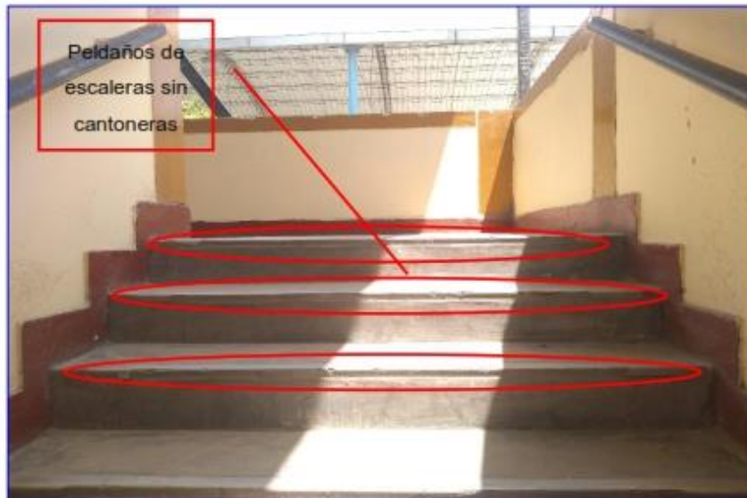
Imagen 18: Escalera de acceso al segundo nivel
