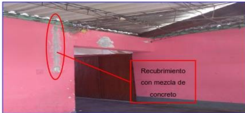
Imagen 24: Recubrimiento de picado de muro para instalaciones eléctricas.
