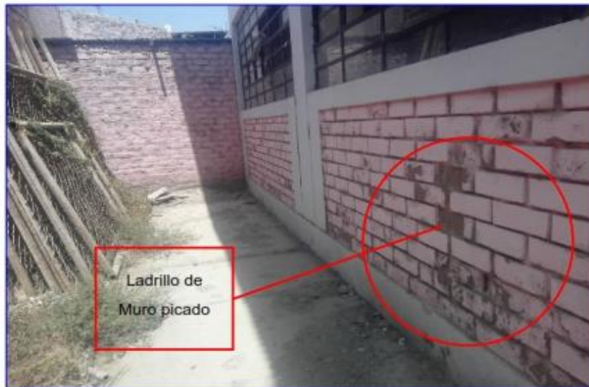
Imagen 20: Vista posterior Pabellón "B", al fondo pared de Kiosco
