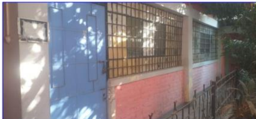
Imagen 26: Puertas y ventanas metálicas.
