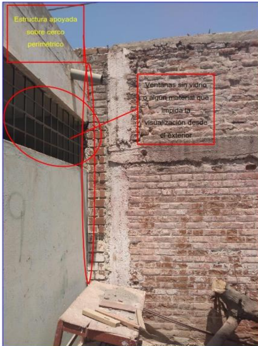
Imagen 45: Encuentro de Servicios Higiénicos con Cerco Perimétrico.
