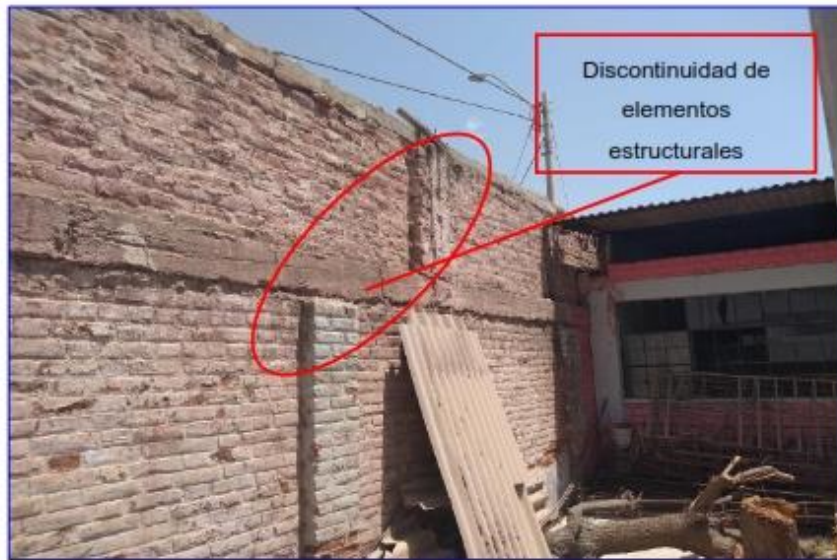
Imagen 64: Discontinuidad de elementos en cerco perimétrico.
