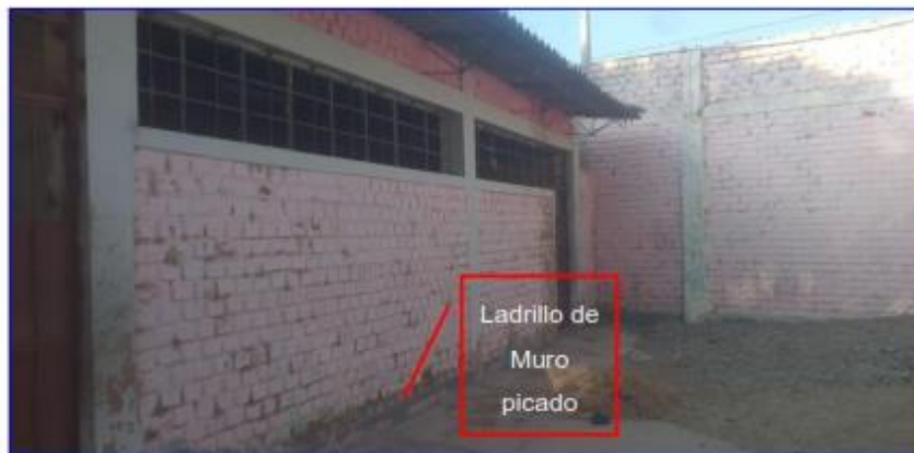
Imagen 9: Aula N°17 antes del mantenimiento
