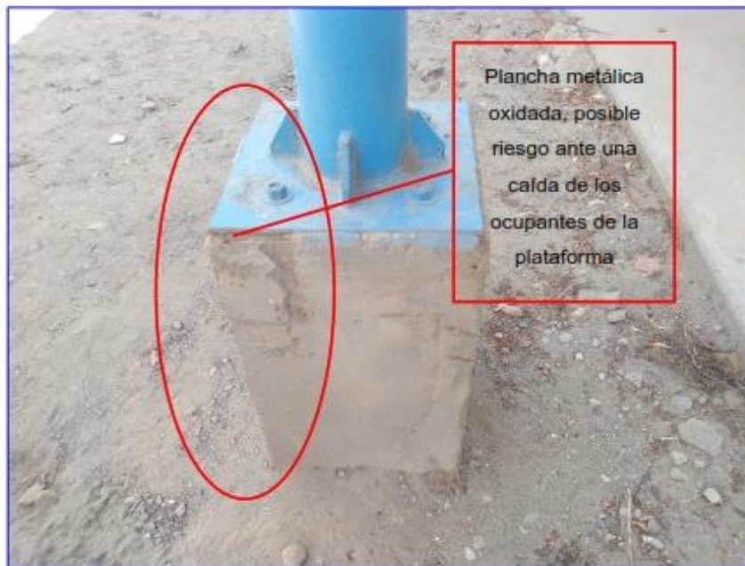
Imagen 49: Plancha de anclaje entre columna metálica y dado de concreto
