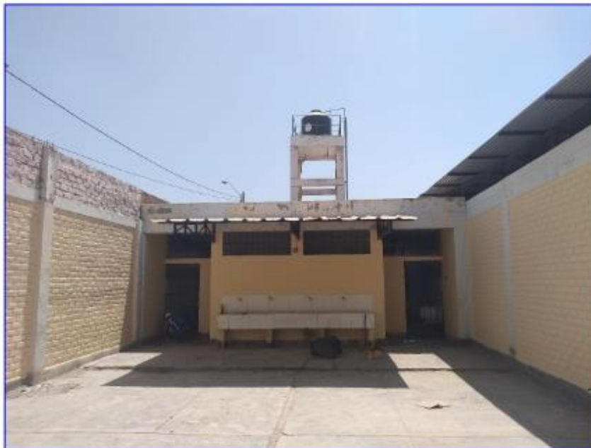
Imagen 42: Vista frontal servicios higiénicos.
