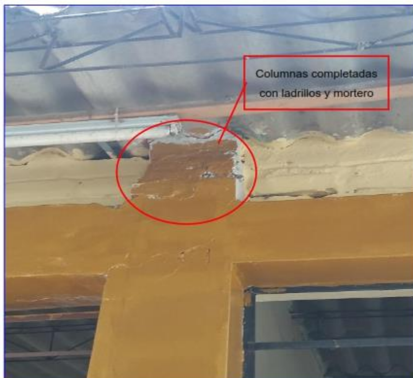
Imagen 12: Columnas completadas con ladrillo
