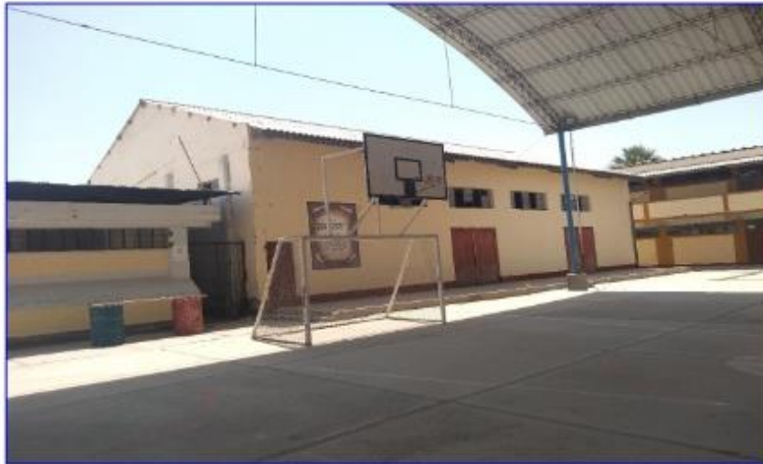
Imagen 37: Pabellón "E" vista frontal
