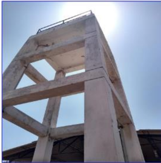
Imagen 58: Pintura descascarada.
