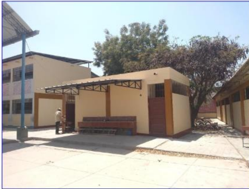
Imagen 60: Vista frontal servicios higiénicos.
