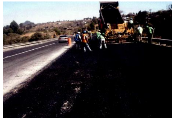
Figura 8. Microfrezado de carpeta
