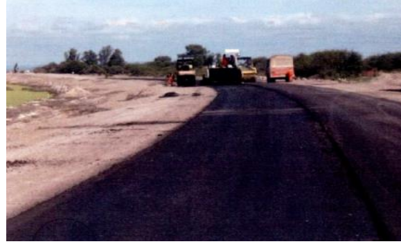
Figura 6. Recapeos asfáltico
