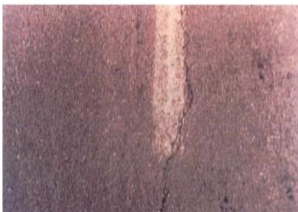
Figura 2. Fisuras longitudinales
