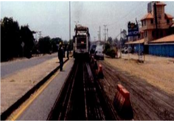
Figura 9. Fresado de carpeta asfáltica
