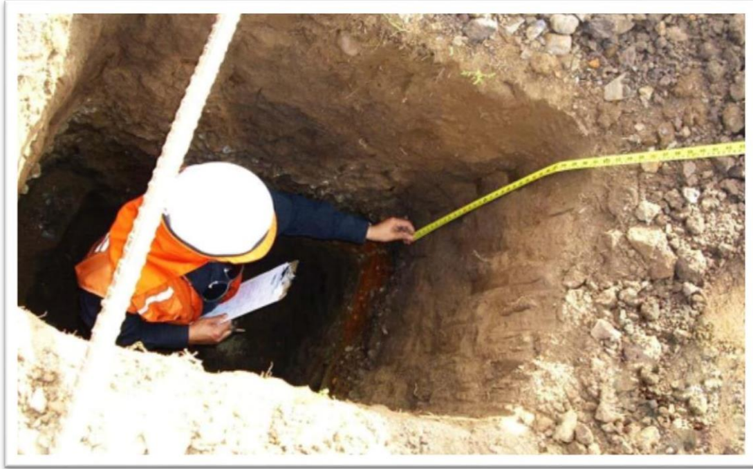
Figura 1: Construcción de una calicata.
