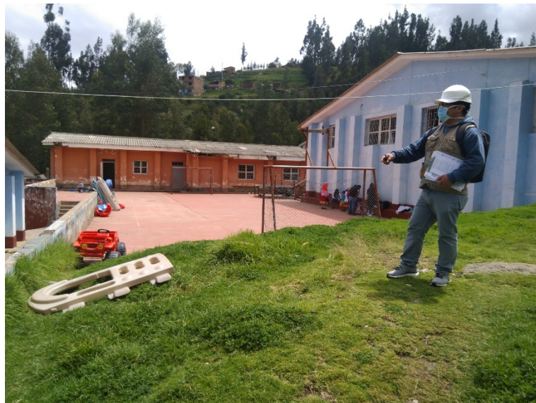
Campo Deportivo, Fachada Principal del auditorio E y Espalda del Bloque A.
