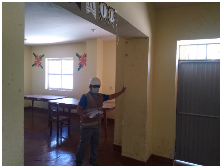
Interior del Bloque E – Auditorio – Estructura vertical.
