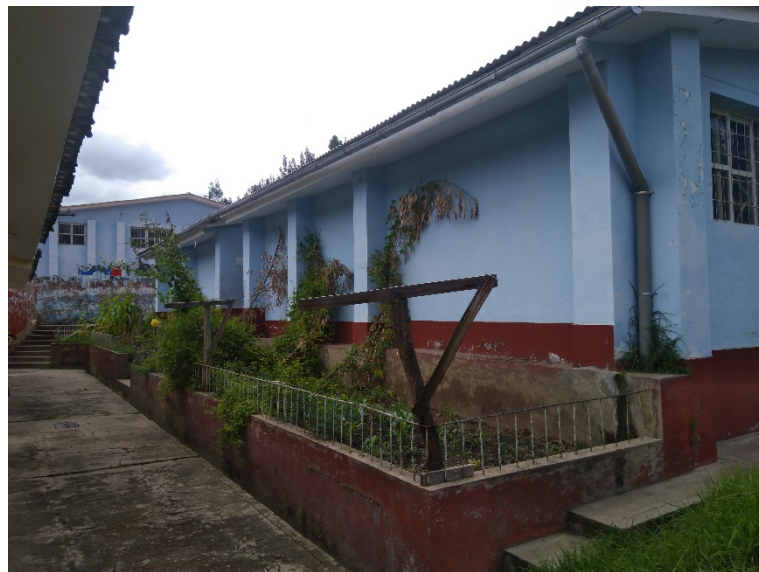
Exterior del Bloque C – C6 – Fachada exterior.
