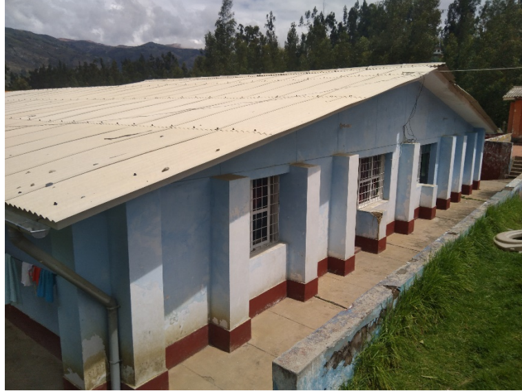
Exterior del Bloque C – Presencia de contrafuertes.
