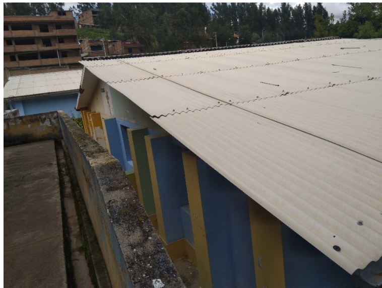
Exterior del Bloque D – Fachada y cobertura.
