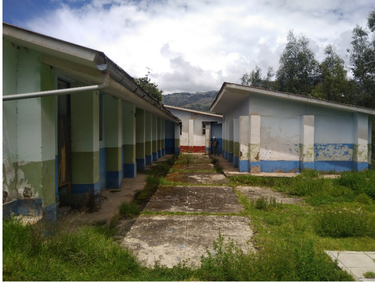
Bloques Abandonados – Edificaciones en desuso, área de circulación.
