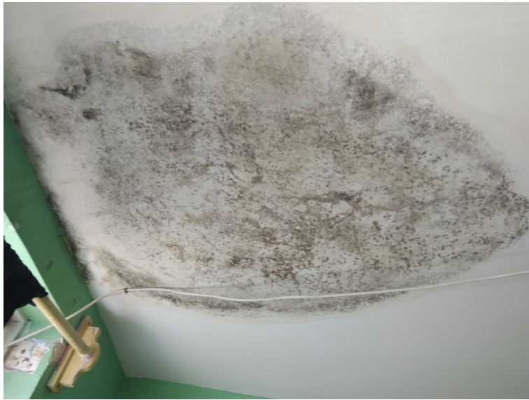
Interior del Bloque C – C6 – Presencia de humedad en el cielo raso.
