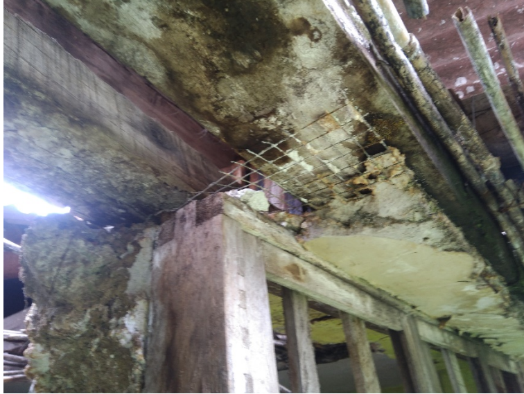
Bloque Abandonado – Malla metálica en tarrajeo.
