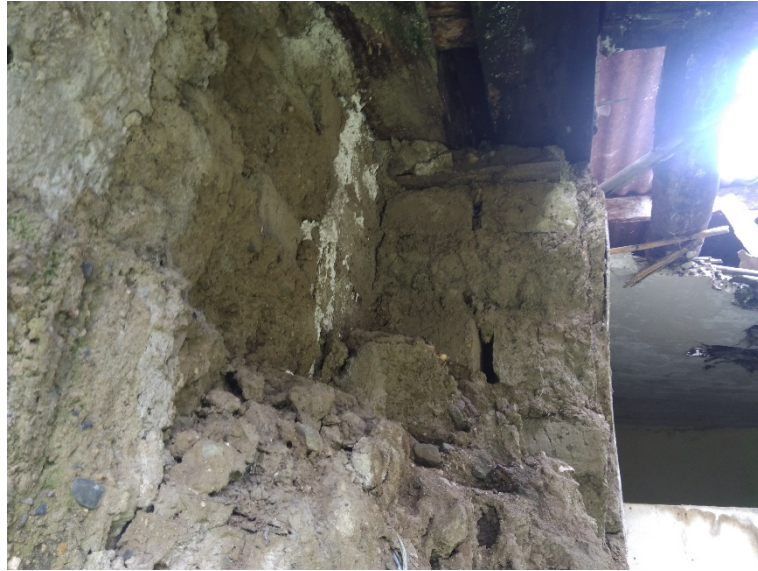
Bloque Abandonado – Aparejo de adobes y juntas.
