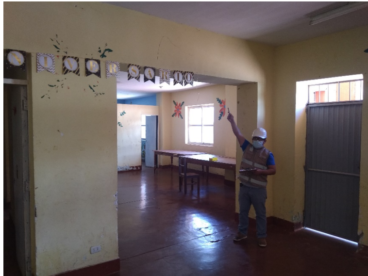
Interior del Bloque E – Auditorio – Estructura horizontal.
