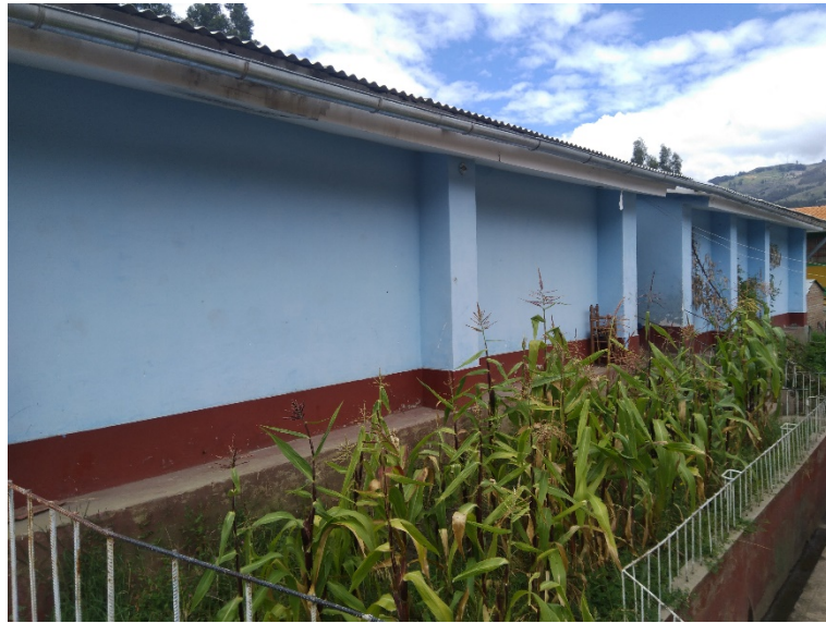
Exterior del Bloque C – C6 – Fachada exterior.
