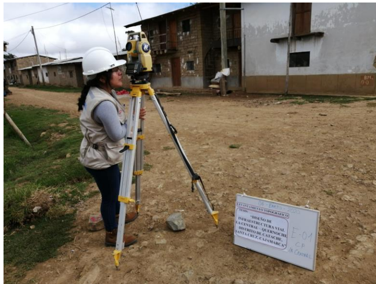
Figura 1: Instalación del equipo TOPCON ES105 en la primera estación (E-01)
