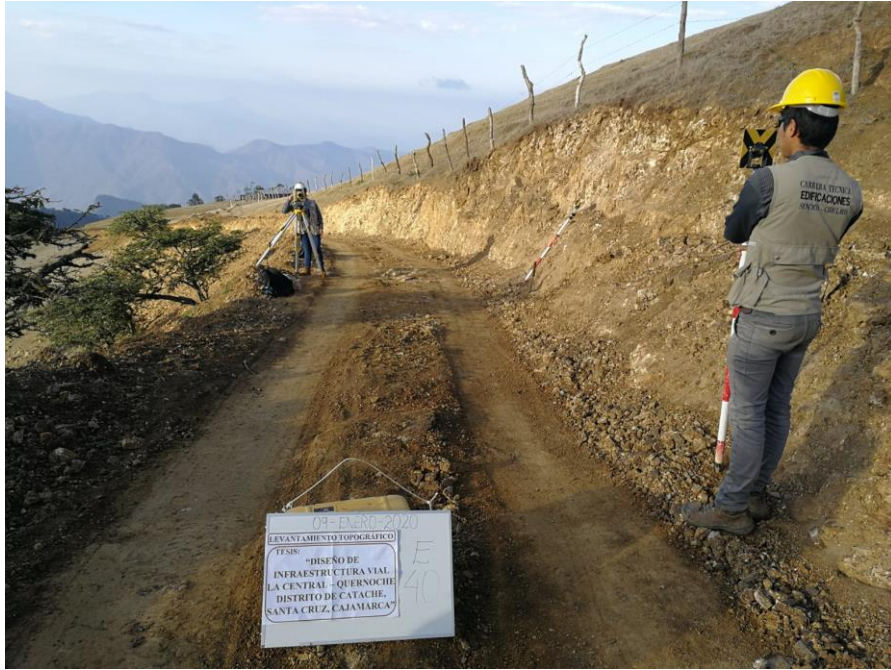
Figura 6: Detalle de plataforma y talúd
