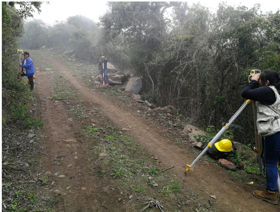
Figura 5: Plataforma de carretera
