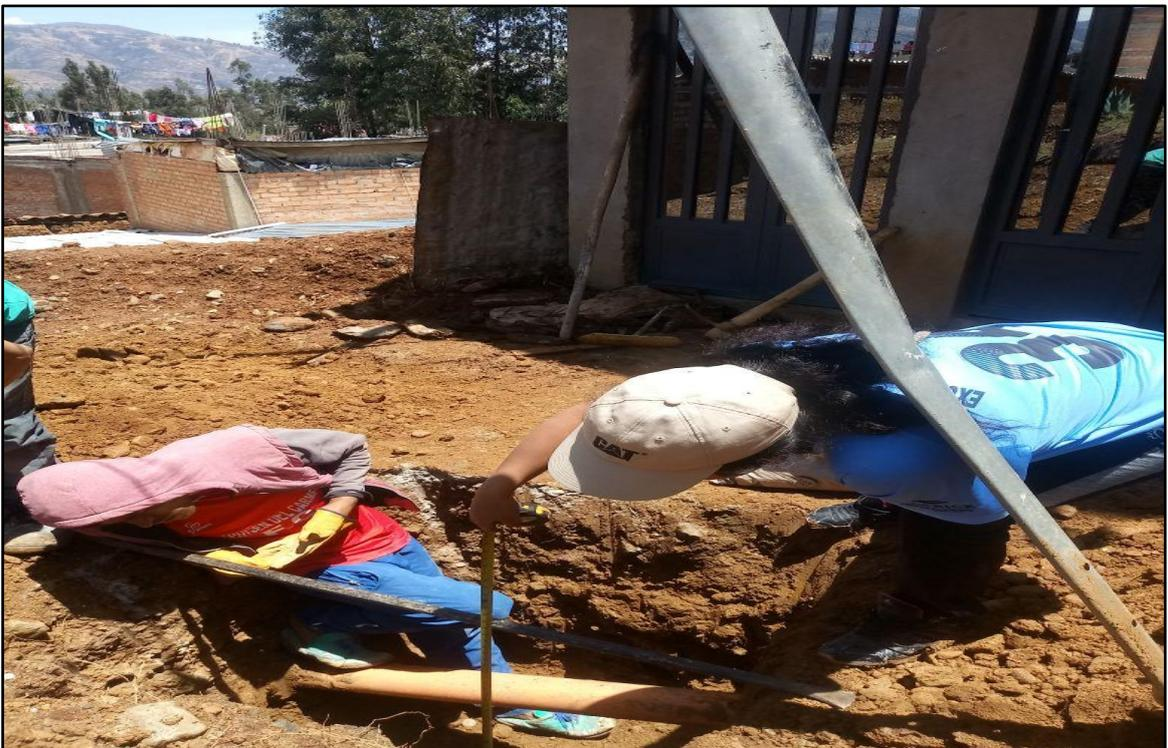
**Figura 19:** Se observa la toma de medida de la calicata para la realización de los ensayos de suelos respectivos en laboratorio = 1.50m
