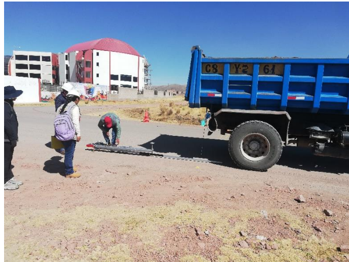
FOTOGRAFÍA N° 4: Encendido del vibrador de la viga
