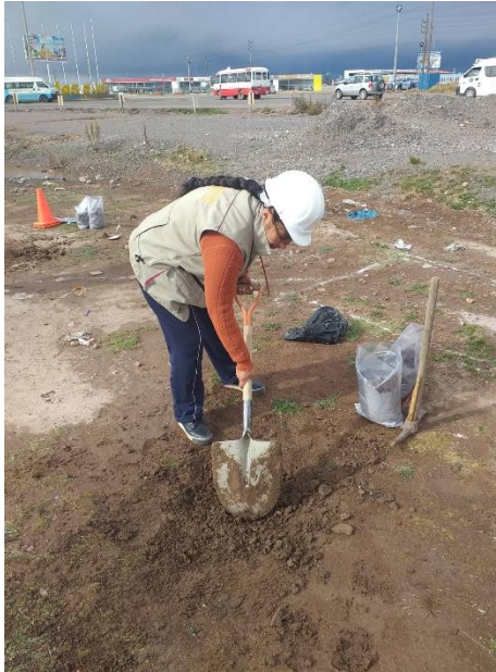
FOTOGRAFÍA N° 8: Muestras de base y sub base
