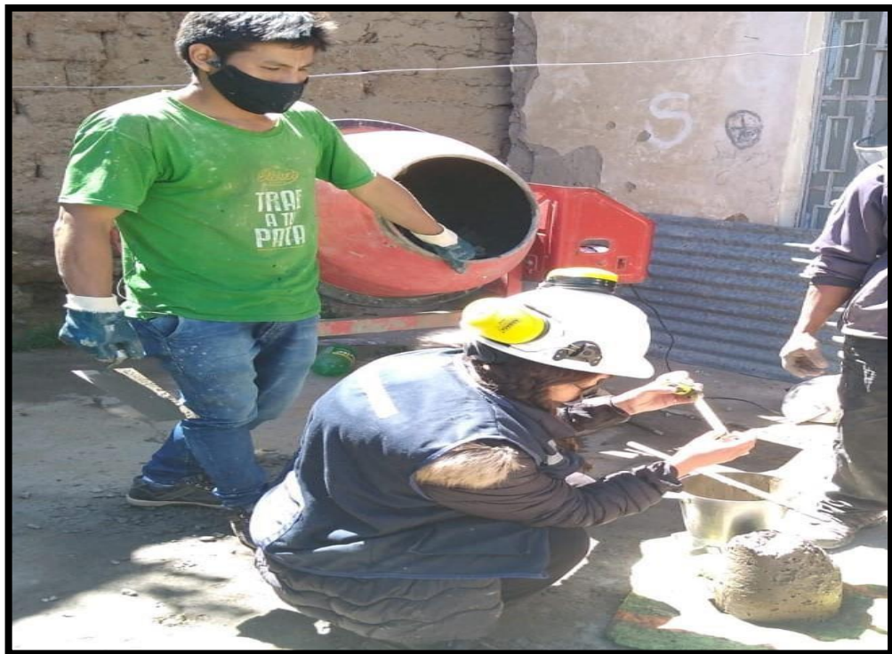
IMAGEN 02: VACEADO DE MEZCLA PARA LA PRUEBA DE ASENTAMIENTO
