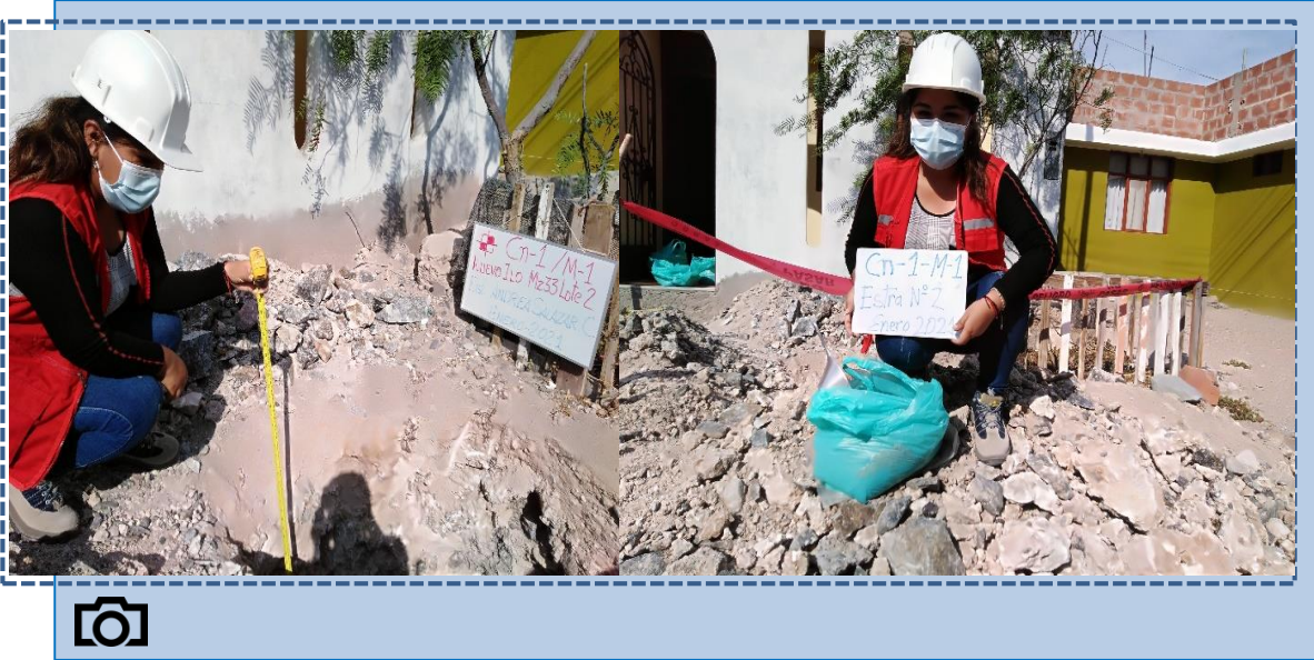
Fotografía 02. Medición y extracción de muestras para los ensayos en laboratorio de suelo.
