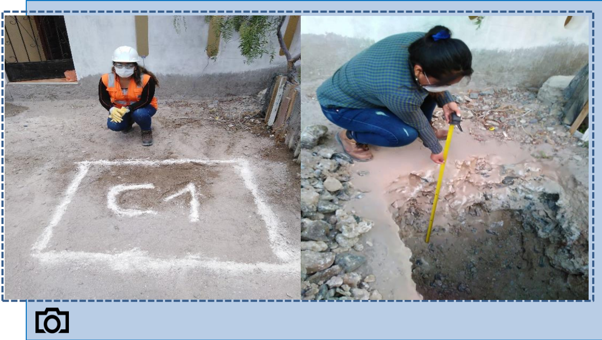
Fotografía 01. Excavación de la Calicata para el estudio de suelo
