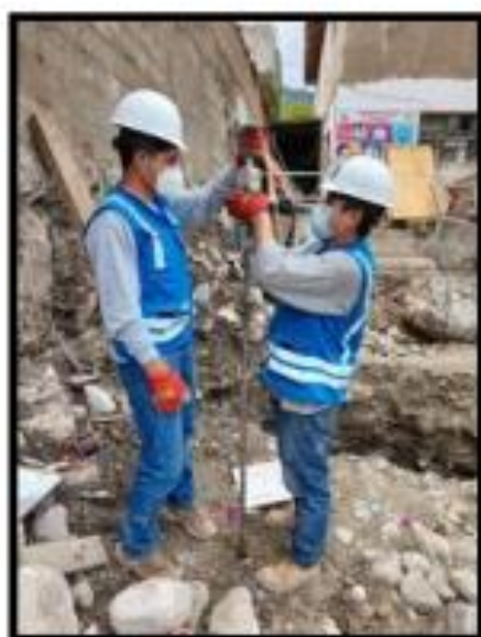
Figura 07 Ensayo de penetración dinámica ligera - C - 02
