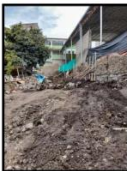
Figura 08 Muro de contención ubicado en la parte superior del bloque 4
