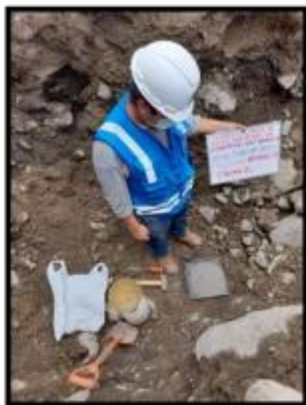
Figura 05 Densidad in situ en la calicata 02
