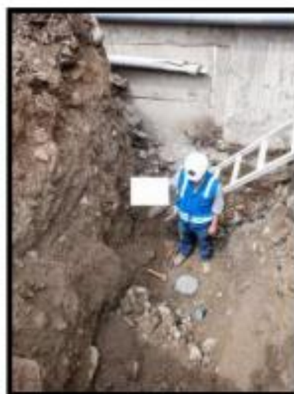
Figura 02 Densidad in situ en la calicata 01
