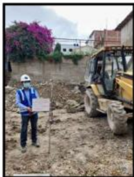
Figura 01 Ensayo de penetración dinámica ligera - C - 01
