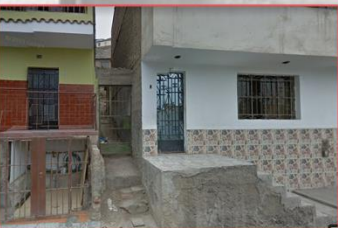
colocación de rejas y tranqueras en distintos accesos del cerro.
