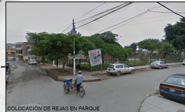
COLOCACIÓN DE REJAS EN PARQUE
