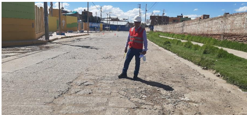
Figura 36. Vista panorámica del tramo 2
