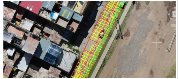
Evaluación de fallas tramo 3
