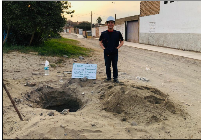
Figura 19: Calicata C-1, se puede apreciar la excavación
