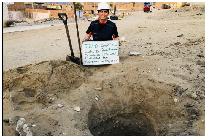
Figura 20: Calicata C-2, se puede apreciar la excavación
