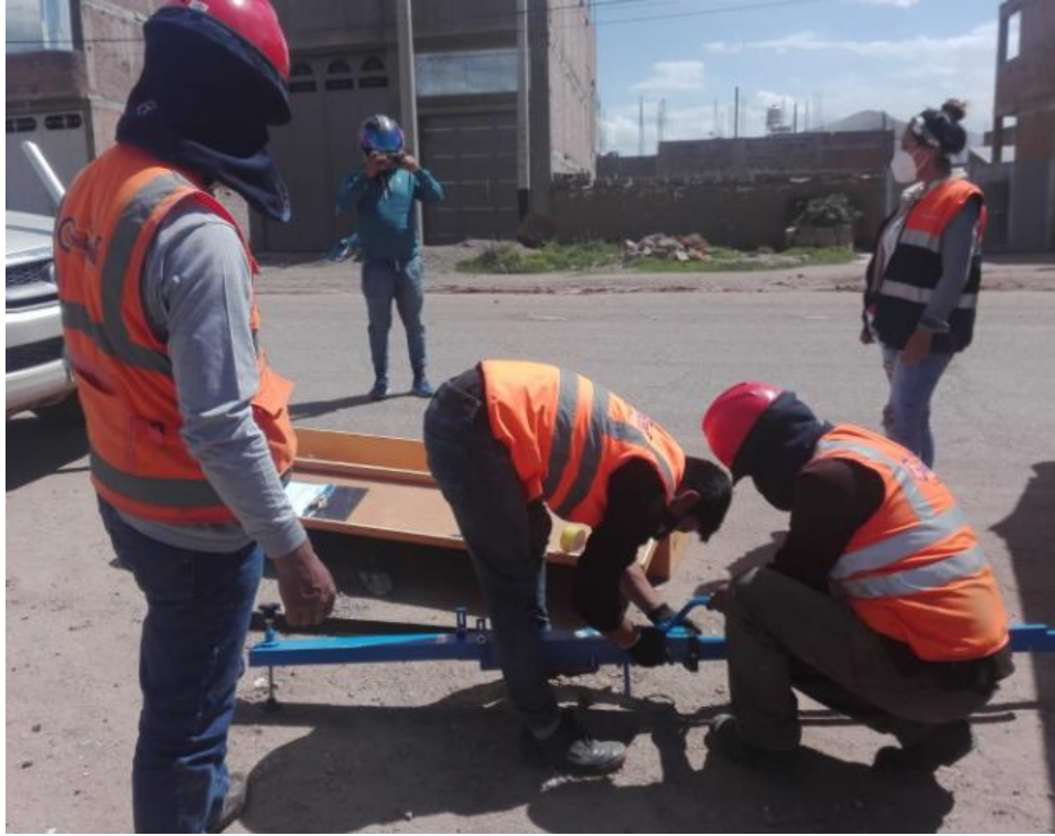
Fotografía 115. "Colocación de los diales en la viga Benkelman"
