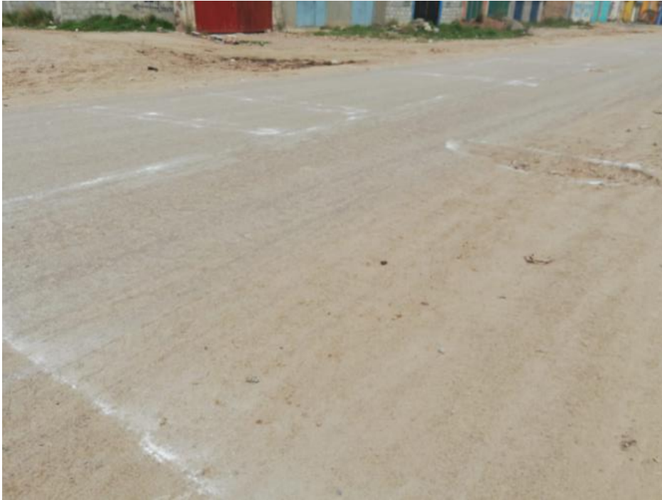
Fotografía 44. "Marcas realizadas de las fallas presentes en la unidad de evaluación N°03"
