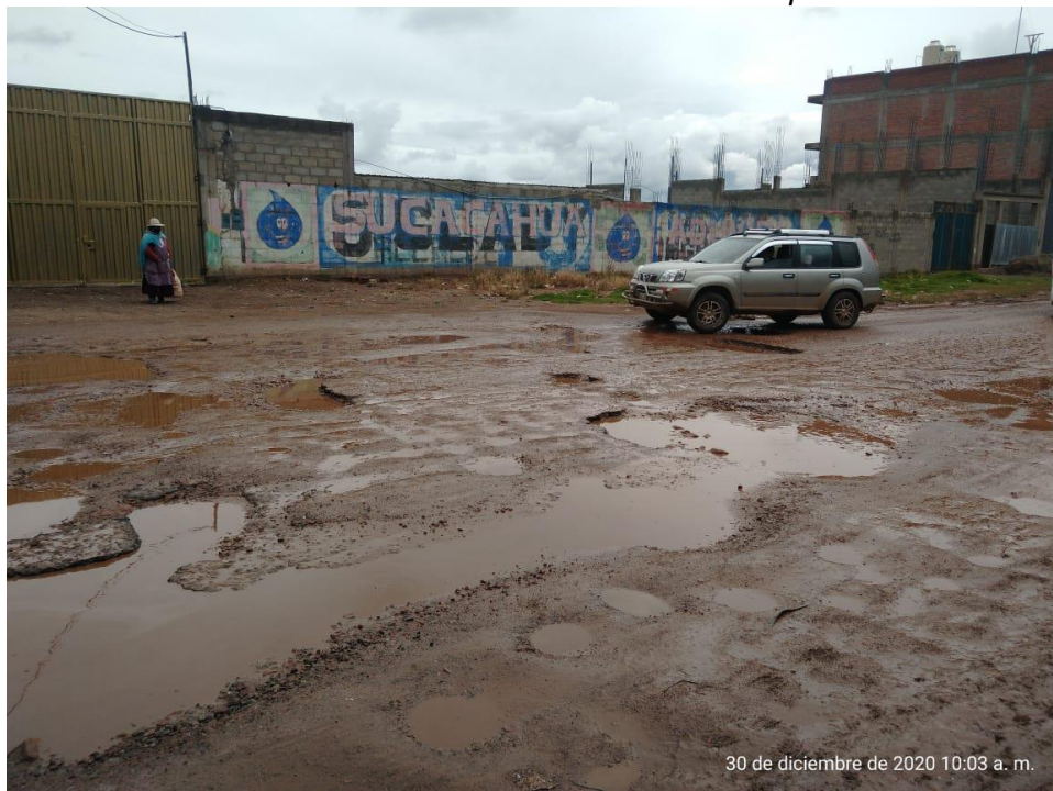
Fotografía 20. "Presencia de huecos en la vía Juliaca - Lampa"
