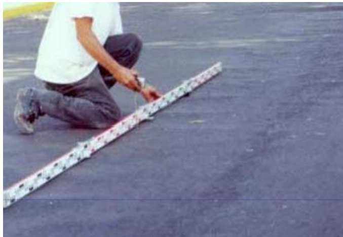
Figura 5. "Presencia de corrugación en pavimentos" Fuente: Solís Baque y Simón Byron (2020)
