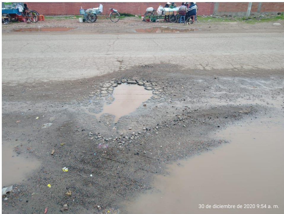
Fotografía 10. "Presencia de piel de cocodrilo, huecos con presencia de agua y desprendimientos ubicada en el tramo 5 de la vía Juliaca - Lampa"
