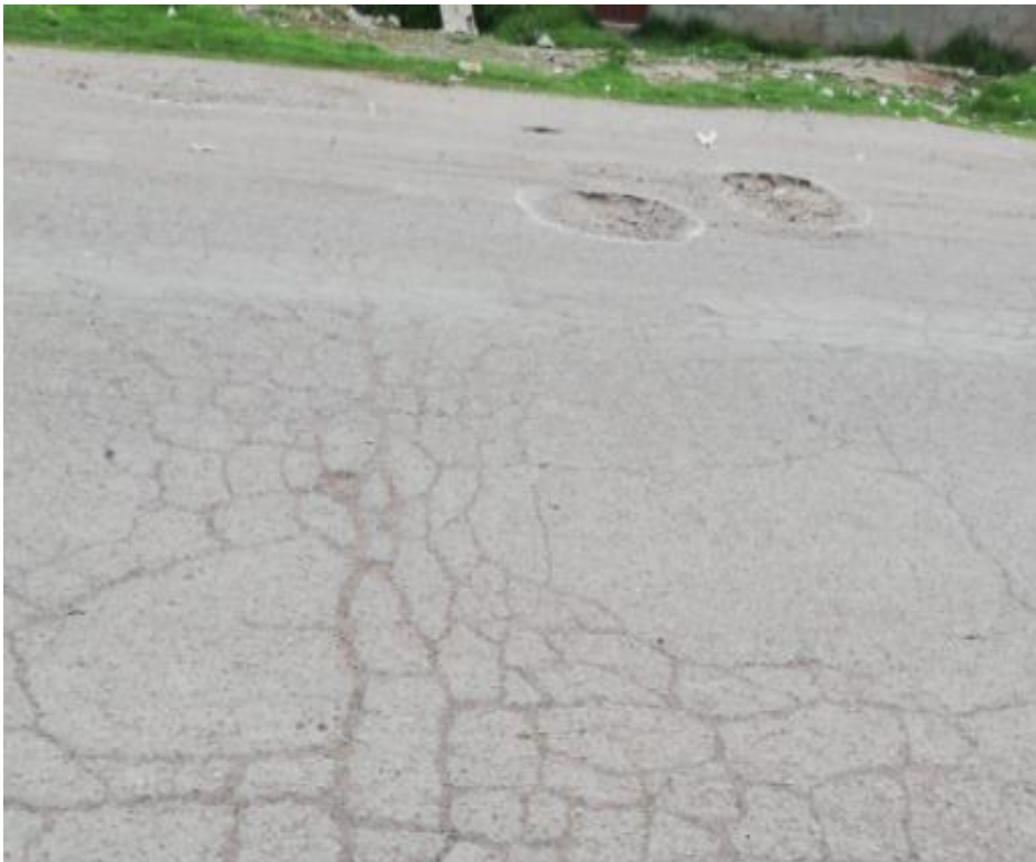
Fotografía 73. "Presencia de piel de cocodrilo, huecos y parches de la unidad de evaluación N°08"
