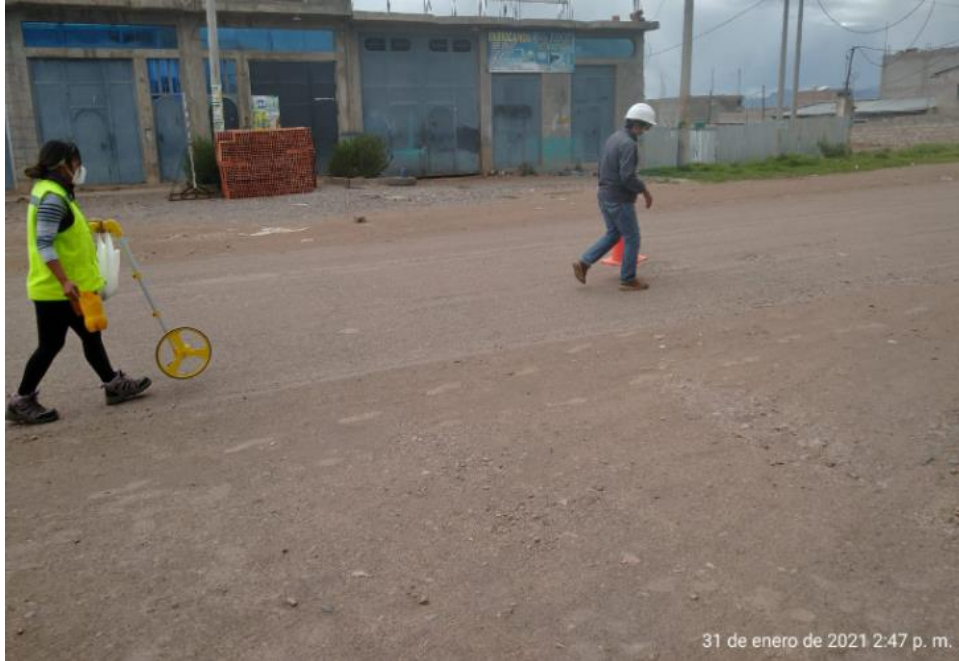
Fotografía 27. "Reubicación del cono de seguridad a medida que pasa el odómetro"
