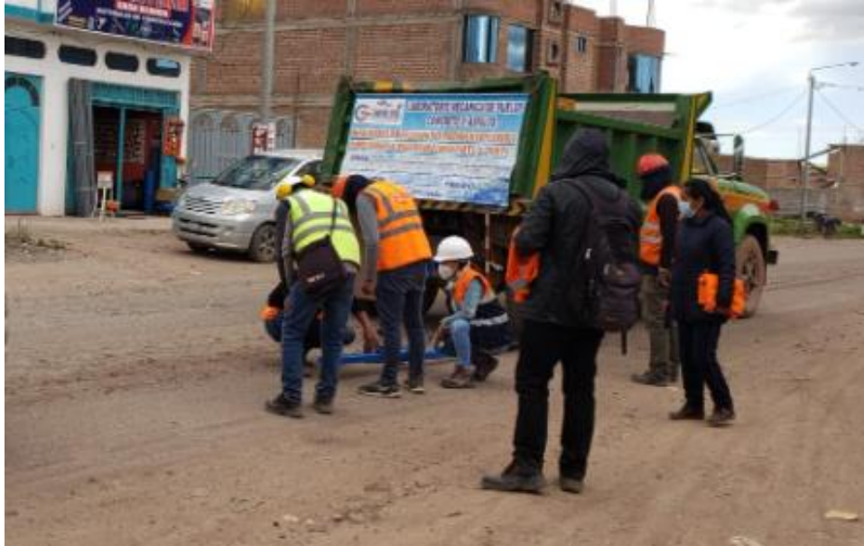
Fotografía 107. "Puesta de los diales en el punto de ensayo"
