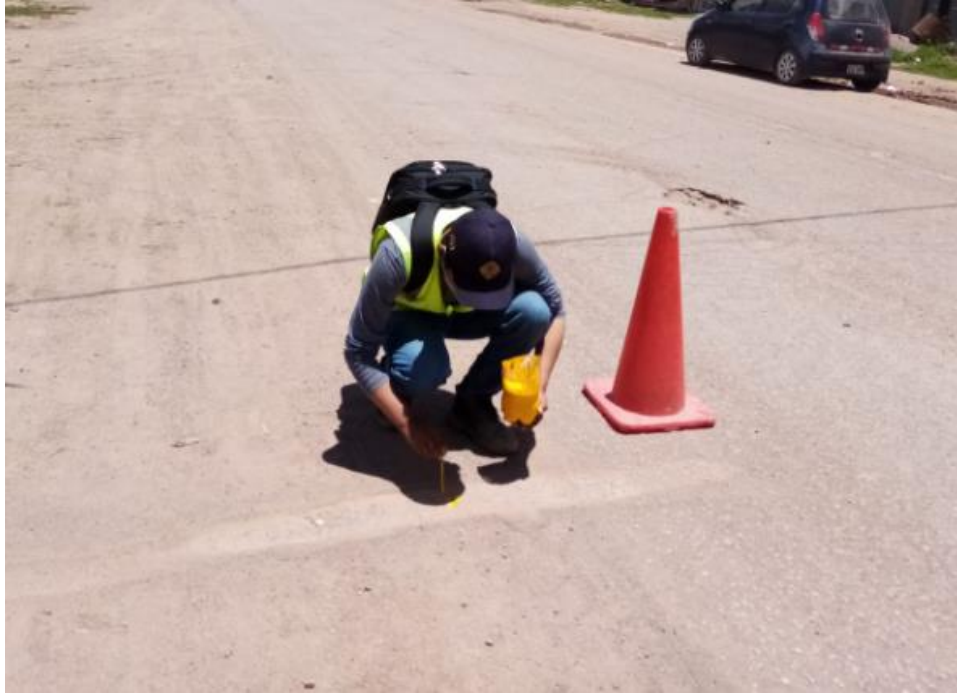
Fotografía 31. "Marcas con pintura de las progresivas en el pavimento flexible"
