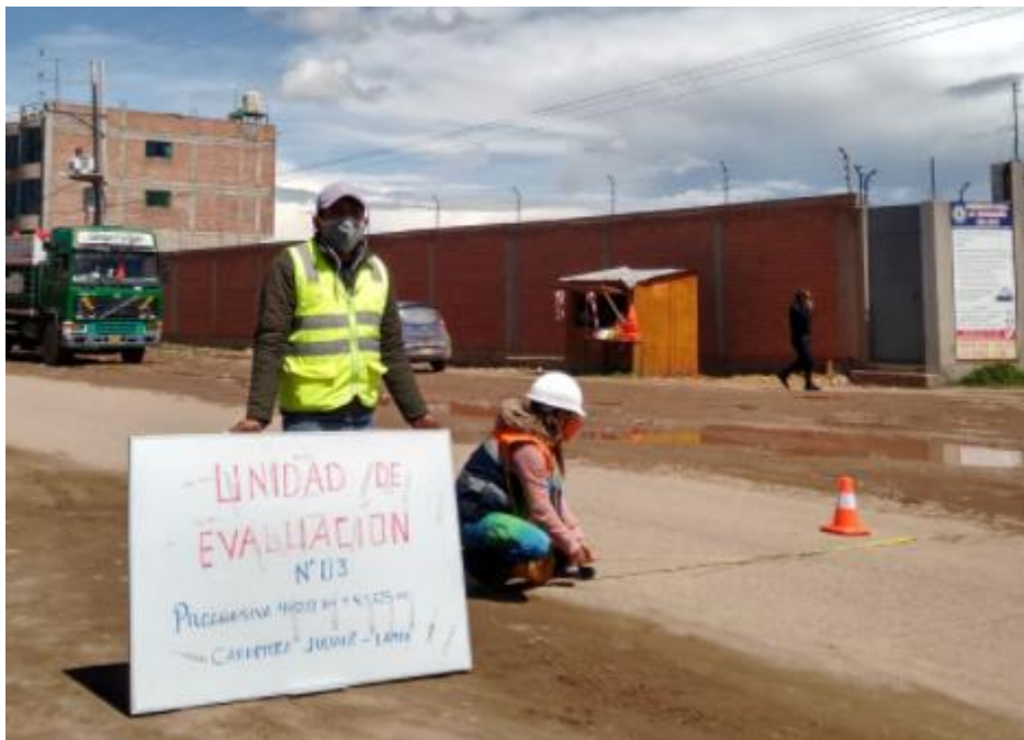
Fotografía 43. "Ubicación de la unidad de evaluación N°03 de progresivas km04+200 al km04+225"
