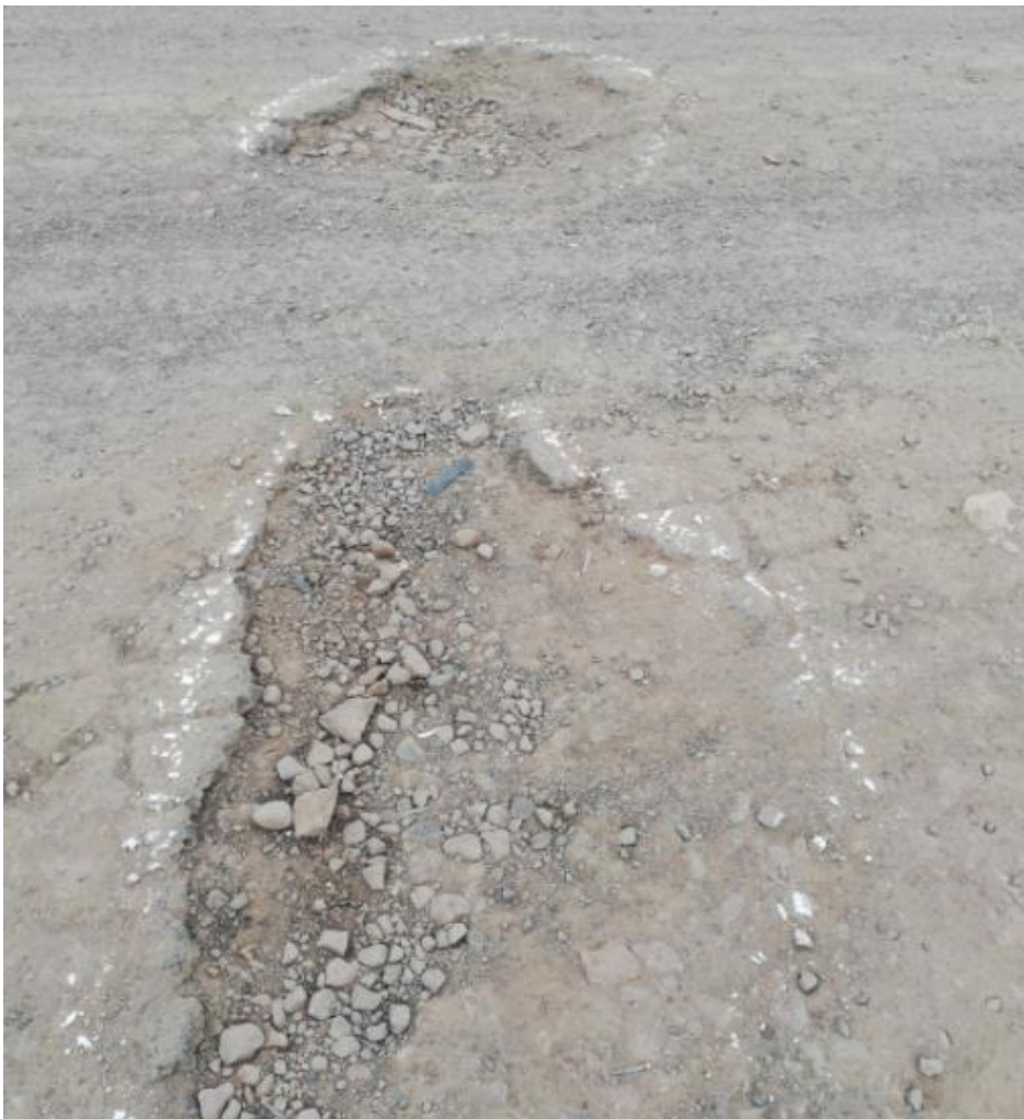
Fotografía 83. "Presencia de huecos de severidad alta en la unidad de evaluación N°09"
