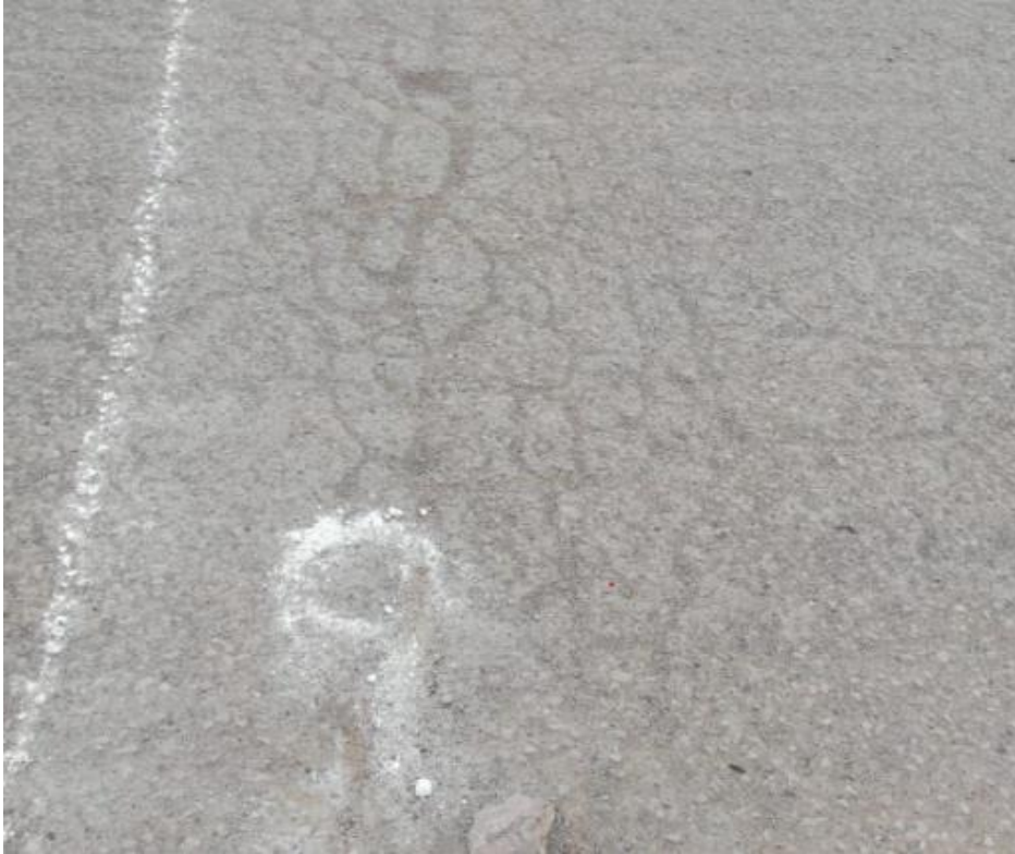
Fotografía 78. "Presencia de piel de cocodrilo en la unidad de evaluación N°09"
