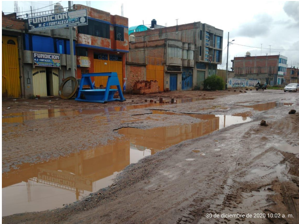
Fotografía 19. "Presencia de baches, huecos con empozamiento de agua causada por las lluvias en la carretera Juliaca - Lampa"
