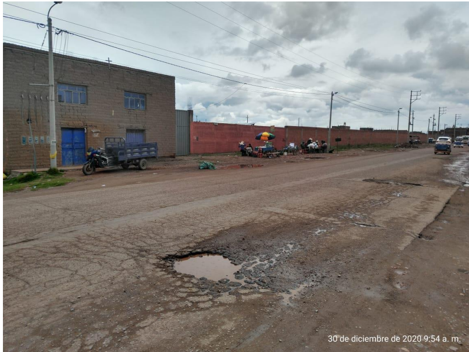
Fotografía 9. "Presencia de grietas longitudinales, piel de cocodrilo y huecos con presencia de agua en el tramo 5 de la vía Juliaca - Lampa"
