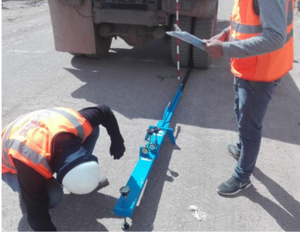
Fotografía 111. "Lectura y registro de los diales en el punto ensayado"
