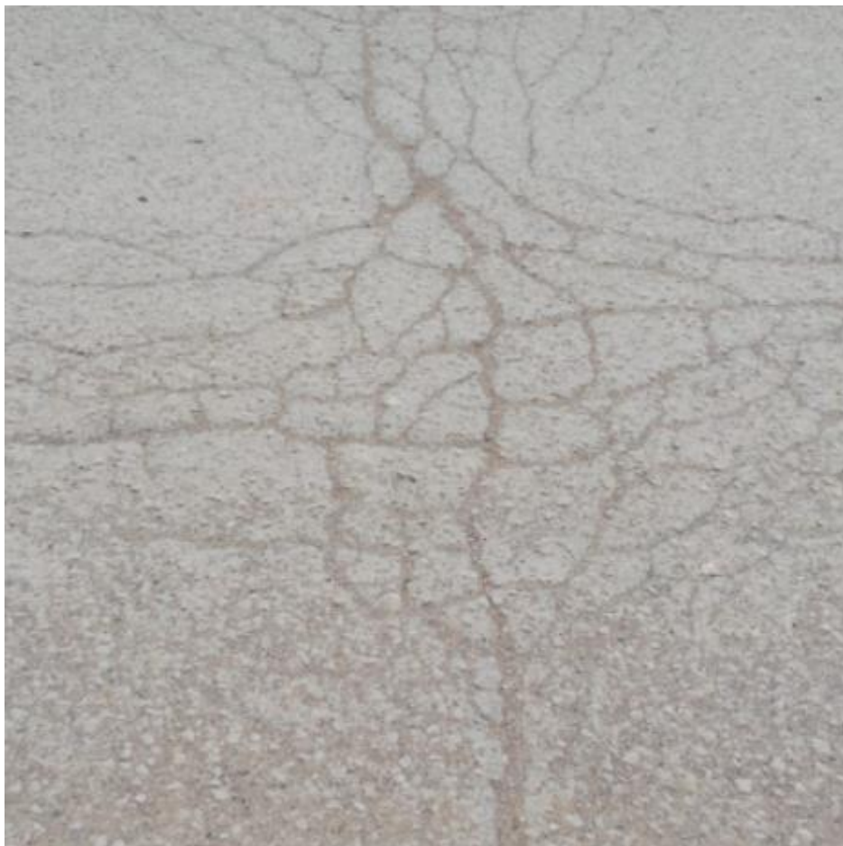
Fotografía 101. "Presencia de piel de cocodrilo, grietas longitudinales y desprendimiento de agregados en la unidad de evaluación N°12"
