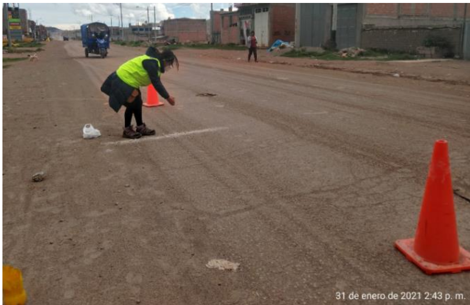
Fotografía 30. "Marcaje temporal de las progresivas en el pavimento"
