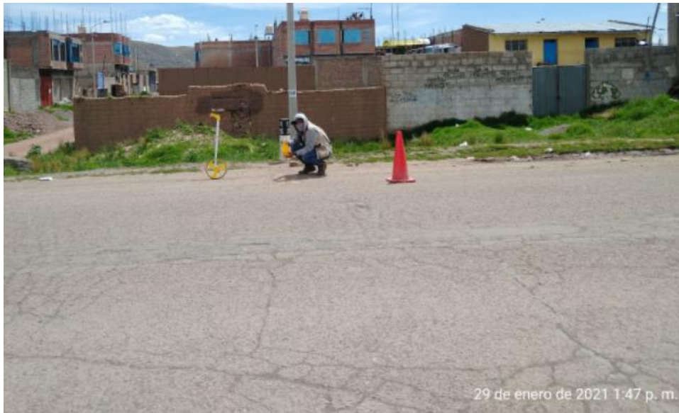
Fotografía 32. "Marca de la progresiva del Km 05+000"
