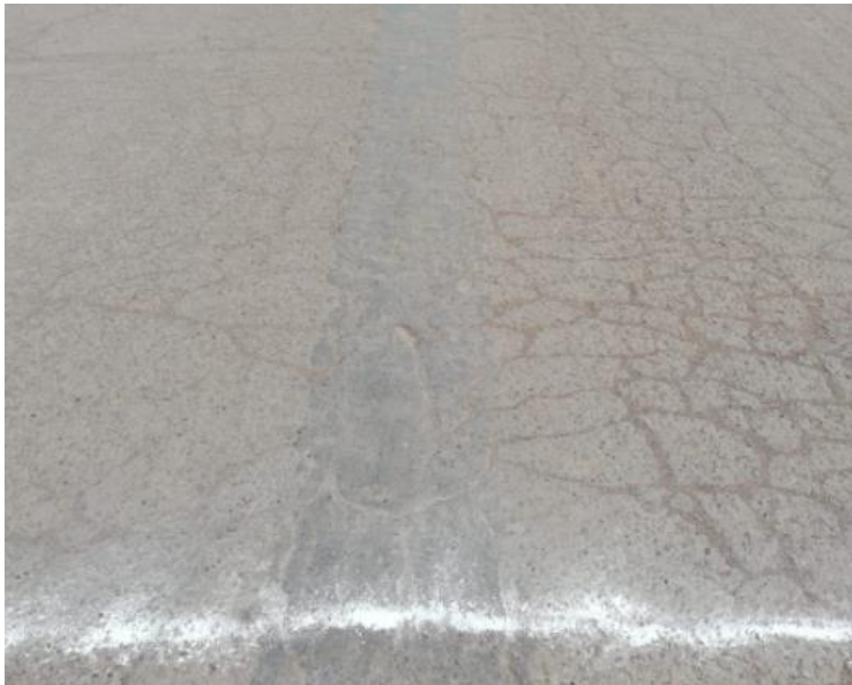
Fotografía 97. "Marca del fin de la unidad de evaluación N°11 y presencia de parche y piel de cocodrilo"
