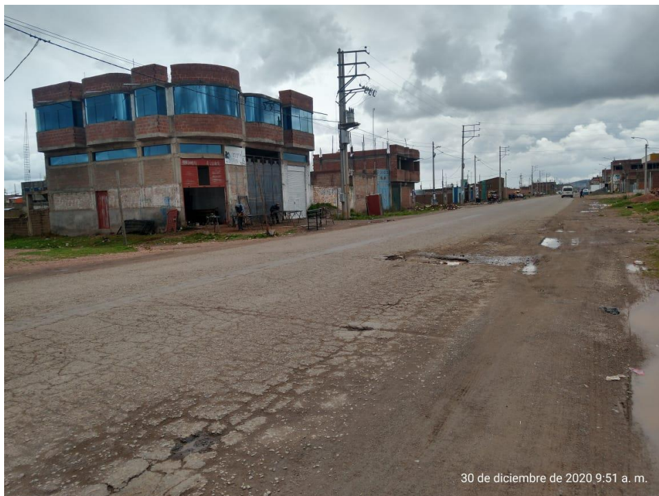
Fotografía 4. "Presencia de piel de cocodrilo, grieta transversal, y huecos con agua en el tramo 5 de la vía Juliaca - Lampa"
