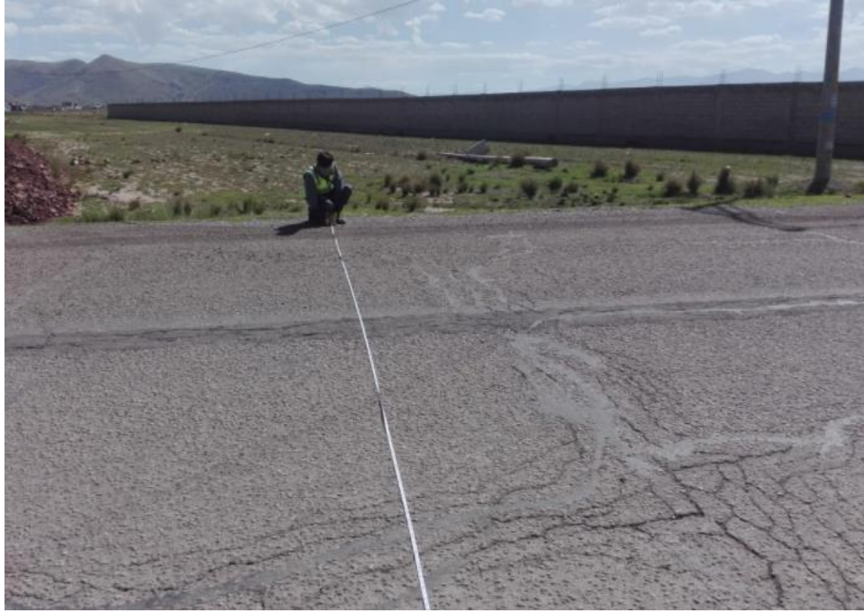
Fotografía 33. "Medición de la calzada del tramo 5 de la vía Juliaca - Lampa"
