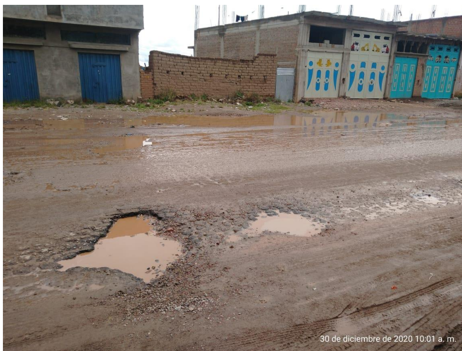
Fotografía 18. "Presencia de baches y piel de cocodrilo en la vía Juliaca - Lampa"
