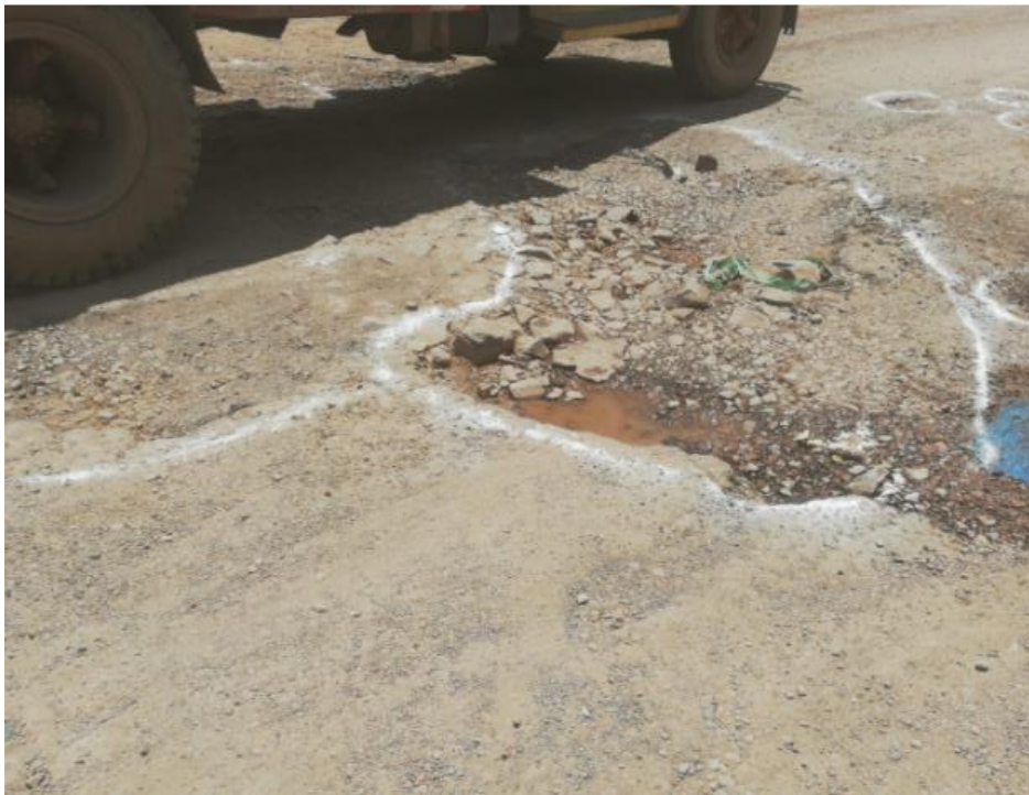
Fotografía 41. "Presencia de huecos con severidad alta en la unidad de evaluación N°02"
