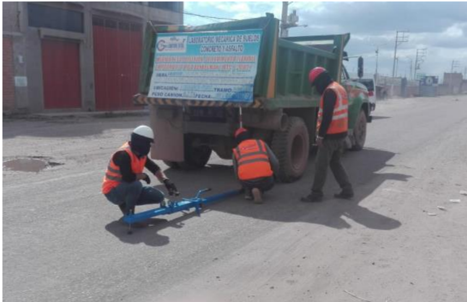
Fotografía 109. "Puesta y verificación de la viga Benkelman en el punto de ensayo"
