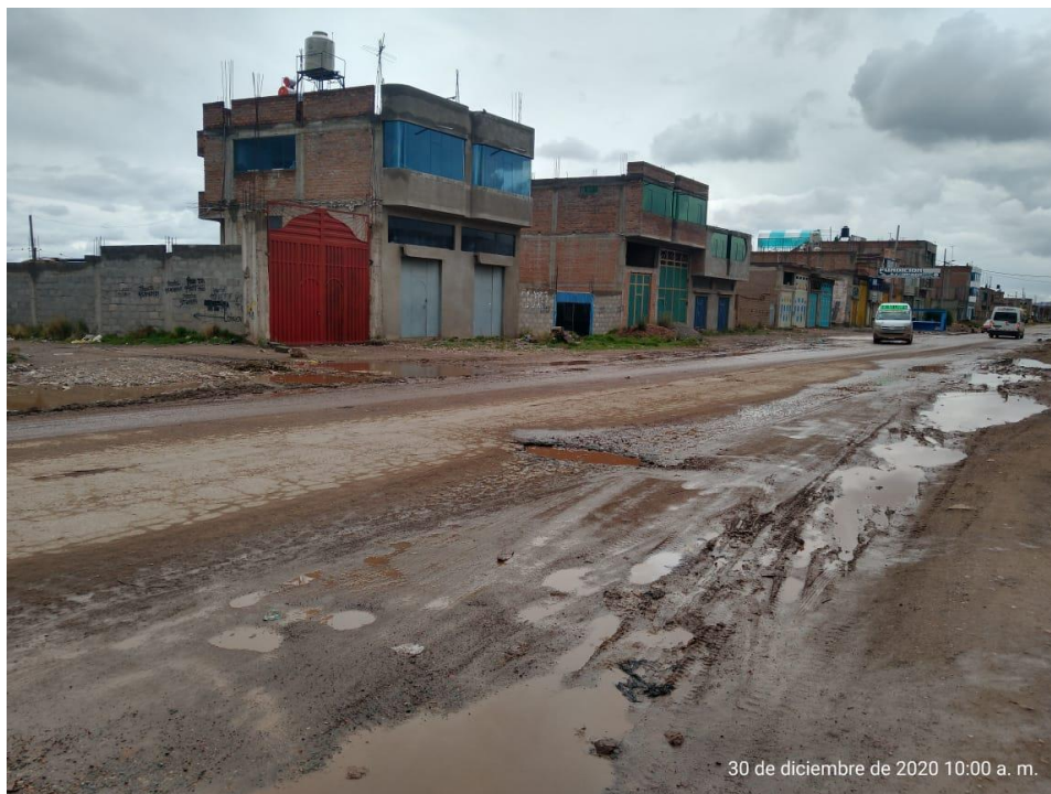
Fotografía 17. "Presencia de huecos, baches en la vía Juliaca - Lampa"
