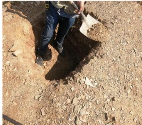
Foto4: Excavación de calicata.
