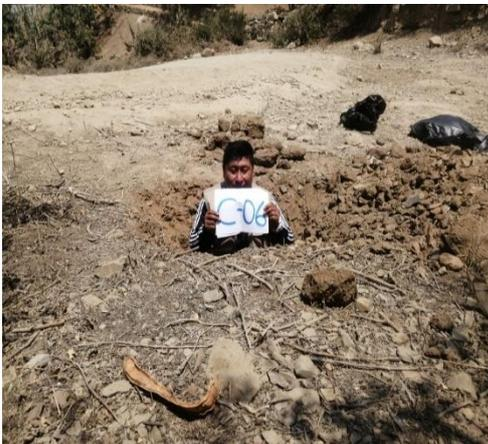
Foto 9: Excavación Calicata nro. 06 .
