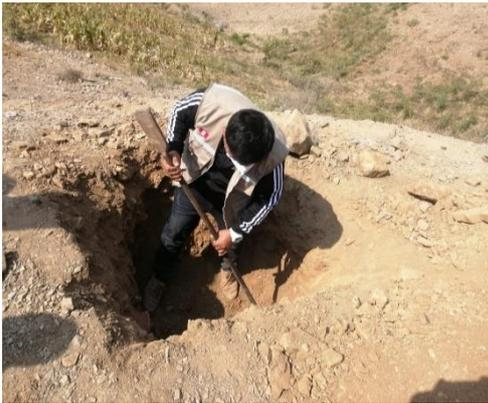
Foto7: Excavación Calicata nro. 03 .
