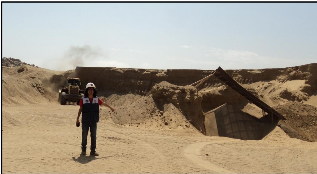
Imagen 02: Extracción de agregado fino en la cantera de Besique. Fuente propia, 2019.
