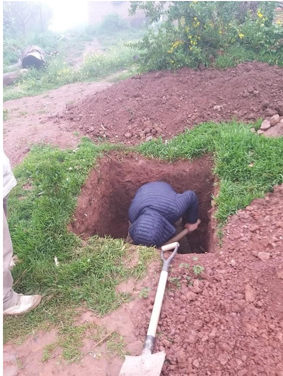
Imagen 9: Vista de la excavación de la calicata C-01 en la prog. 0+040 del tramo Pucaloma - Maukallaqta
