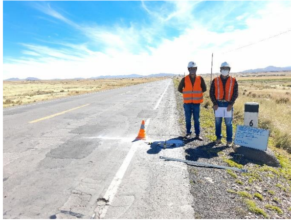
Figura 65. Progresiva Km 6+000 Puente Calapuja-Mataro Grande Fuente. Elaboración propia.
