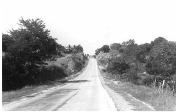
Figura 6. Exudación de Baja Severidad.
