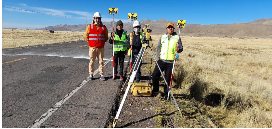
Figura 63. Equipos necesarios para el levantamiento topográfico Fuente. Elaboración propia.
