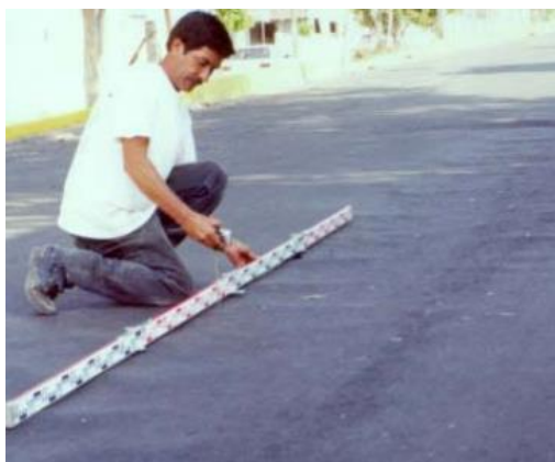
Figura 19. Corrugación de severidad media.
