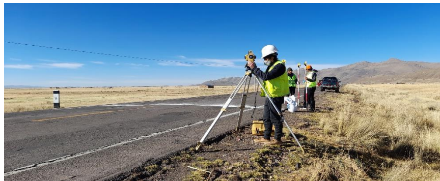
Figura 64. Progresiva Km 6+000 Puente Calapuja-Mataro Grande Fuente. Elaboración propia.
