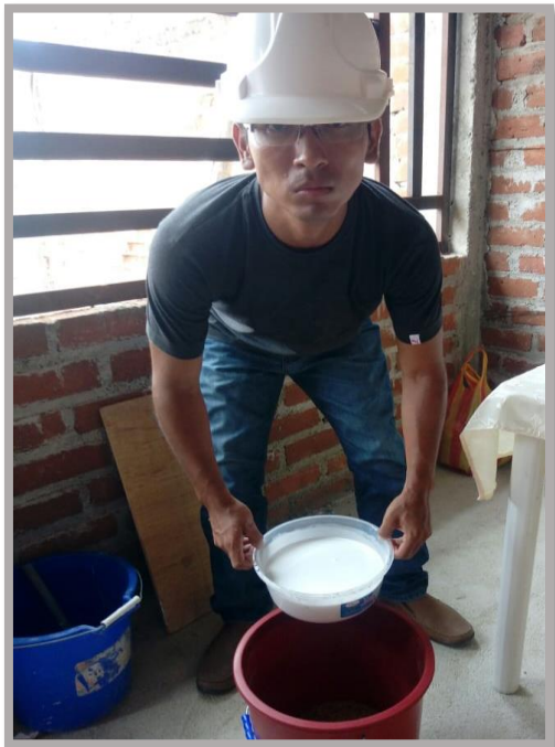
Mezclado de cola con agua, cáscara, yeso
