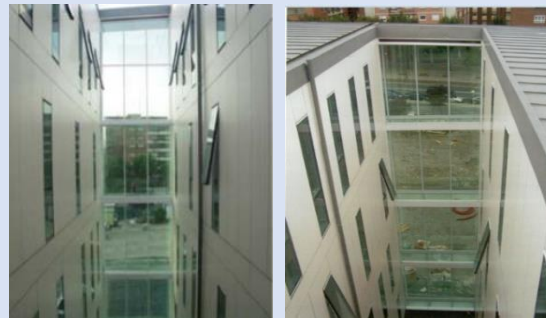
Figura 279: patio del conservatorio de Le Tram Fuente: Nueva sede del conservatorio nacional de música 2018
