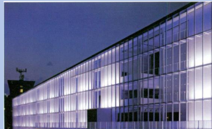
Figura 254: Iluminación de la doble fachada
