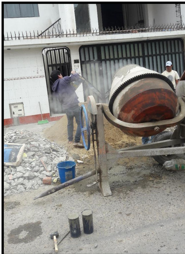
Fotografía N°08 Mezclado a máquina en obra, extracción de muestras cilíndricas
