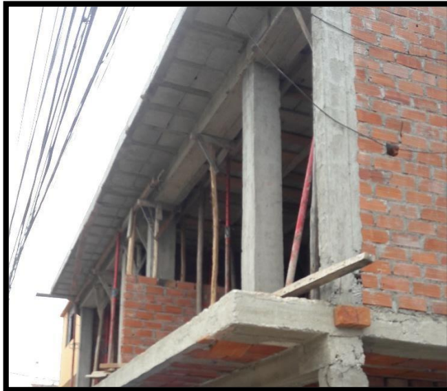
Fotografía N°12 Losa del segundo piso, llena de concreto mezclado con maquinaria
