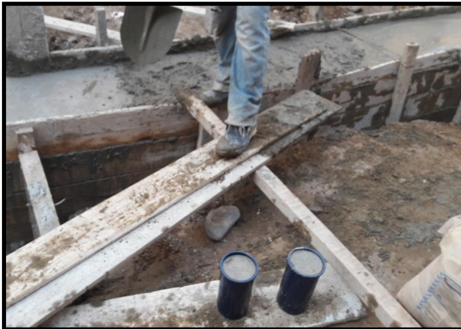
Fotografía N°06 Extracción de muestra, cilindros provenientes de zapatas
