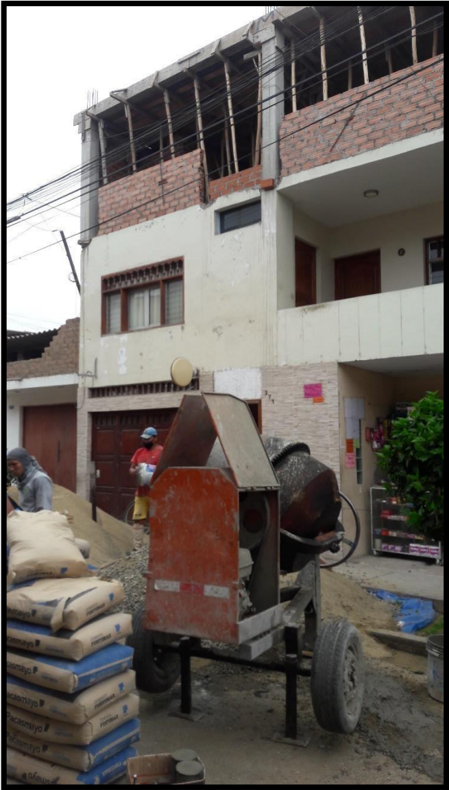
Fotografía N°06 Mezclado con maquina en obra, concreto destinado para losa aligerada
