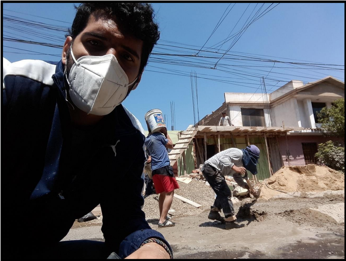
Fotografía N°13 Losa Aligerada del primer piso, llenada con concreto mezclado en obra, manualmente
