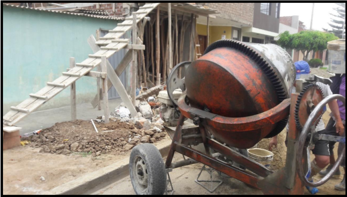
Fotografía N°11 Mezclado a máquina en obra
