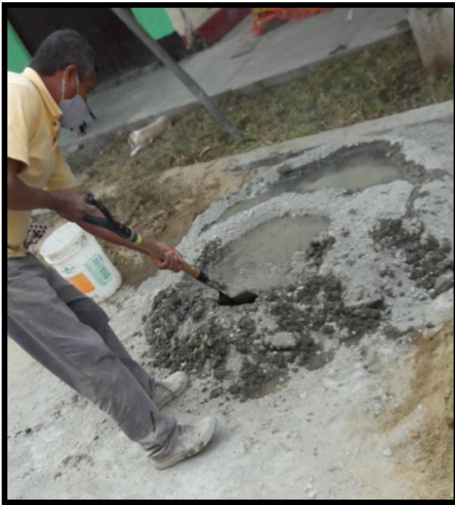
Fotografía N°01 Mezclado manual en obra, no comprendido en la normativa
