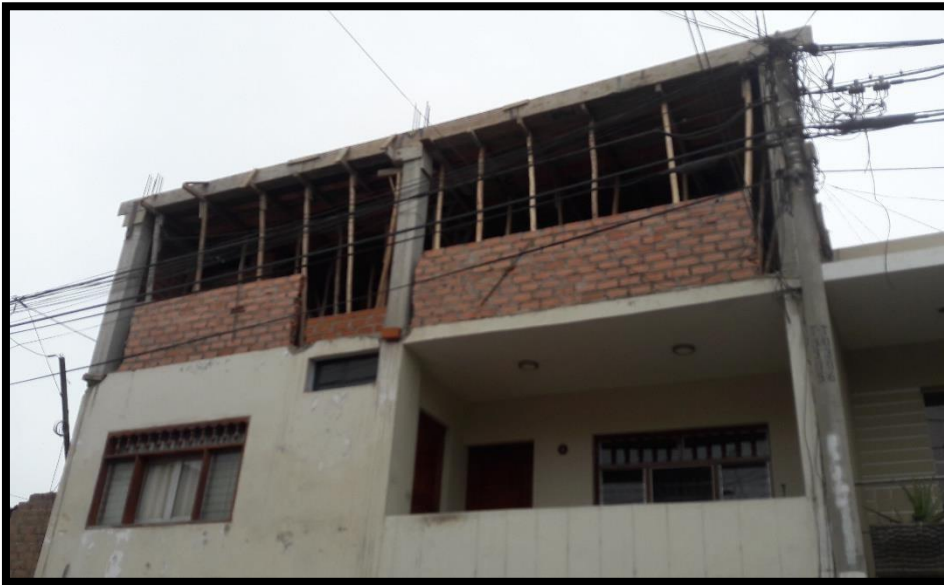
Fotografía N°07 Losa aligerada por llenar, ubicada en un tercer piso
