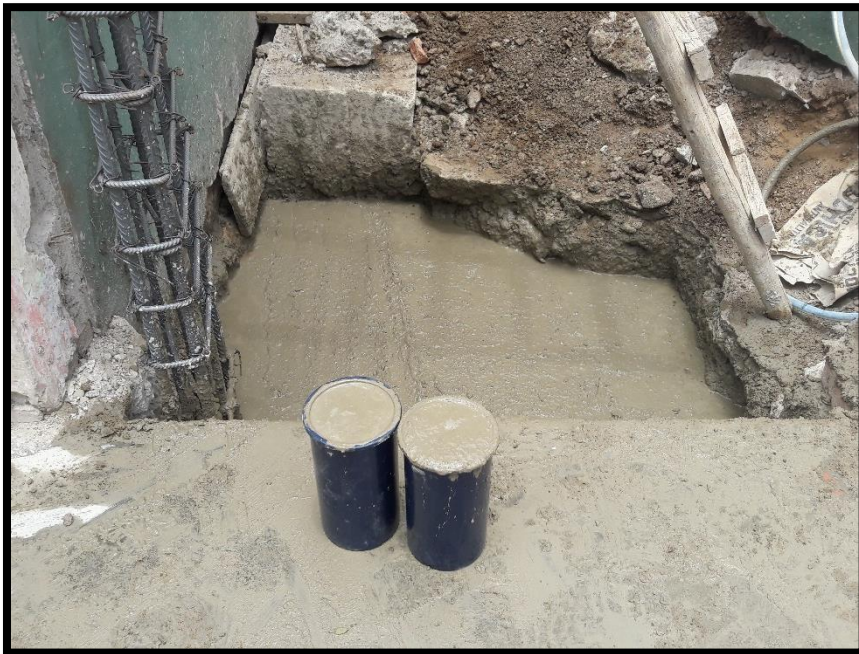
Fotografía N°04 Extracción de muestra, cilindros provenientes de zapatas
