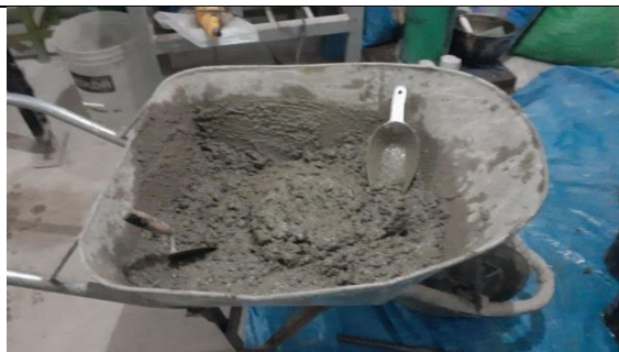
Mezcla de concreto F'c=210\text{kg/cm}^2
