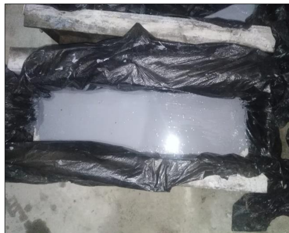
Figura 17: Aplicación del Sikadur en la viga
