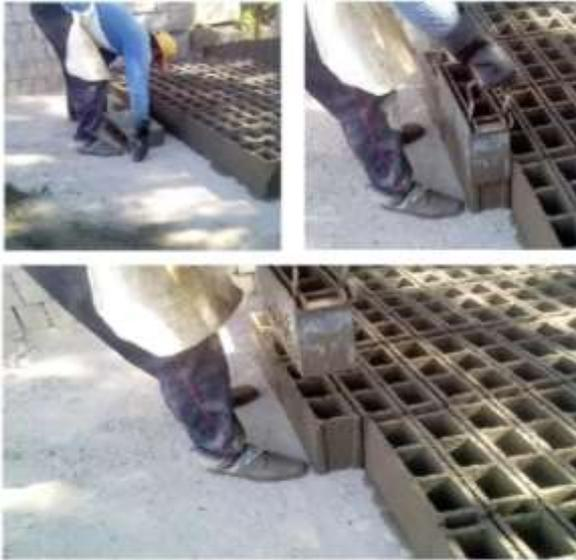
Figura 2.6. Desmolde de las unidades de bloques.
