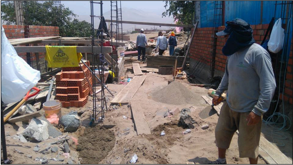
Figura 353. Construcción de casa
