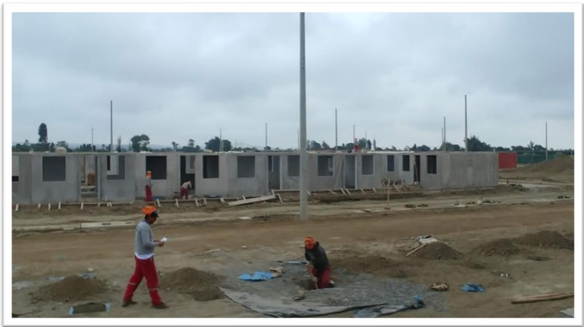
OBREROS EN LABORES
