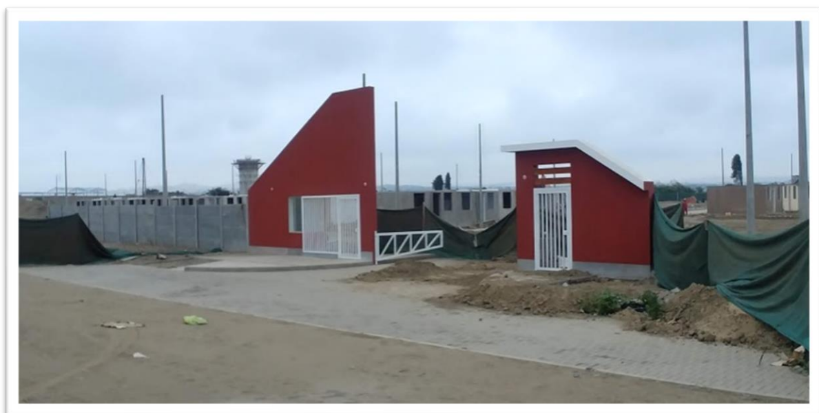
PORTICO PRINCIPAL DEL PROYECTO ALTO CHIMBOTE II
