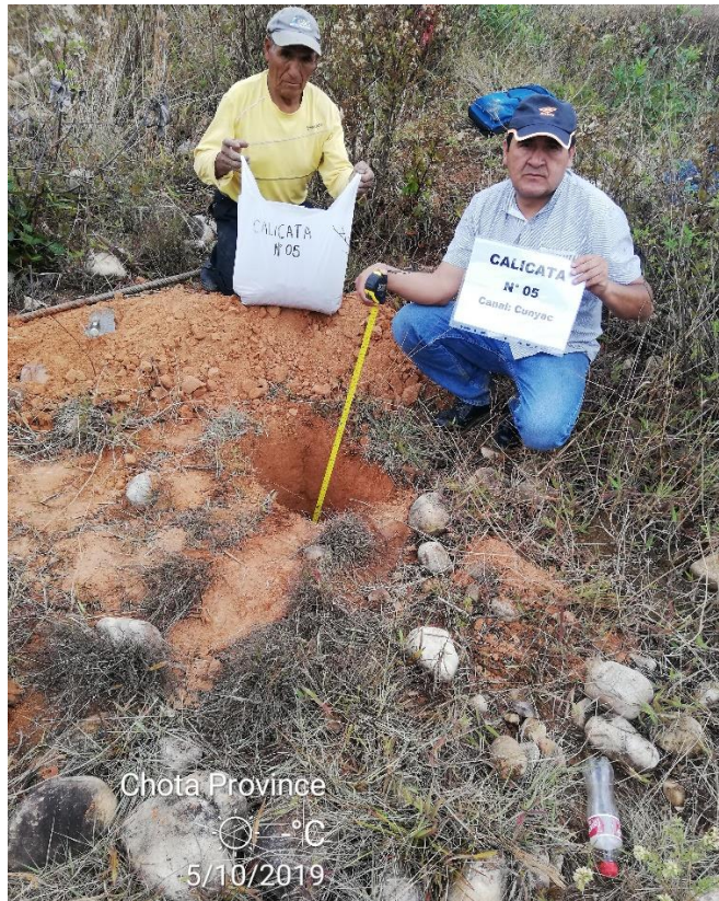
FOTO 10. Final de apertura de calicatas. En la Imagen Calicata N° 05 – Progresiva 0 + 4000
