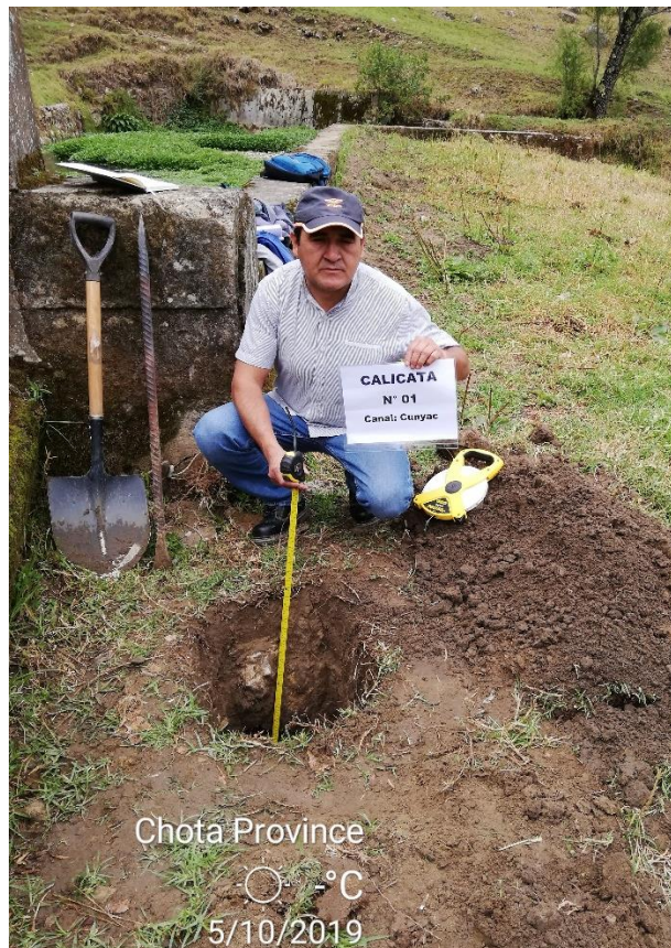
FOTO 9. Inicio de apertura de calicatas. En la Imagen Calicata N° 01 – Progresiva 0 + 0000
