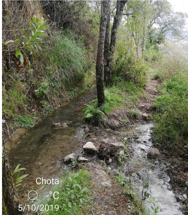
FOTO 8. Problemas de desborde y filtración del Canal Cunyac.
