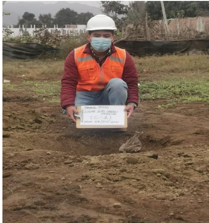
Fotografía 1. Calicata C-1 (cercana a Zapata Eje "L" y Eje "4" - Modulo I)
