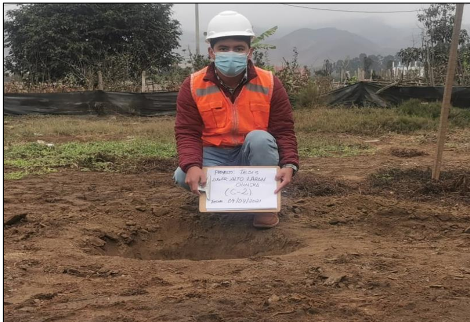
Fotografía 2. Calicata C-2 (cercana a Zapata Eje "G" y Eje "4" – Modulo II)
