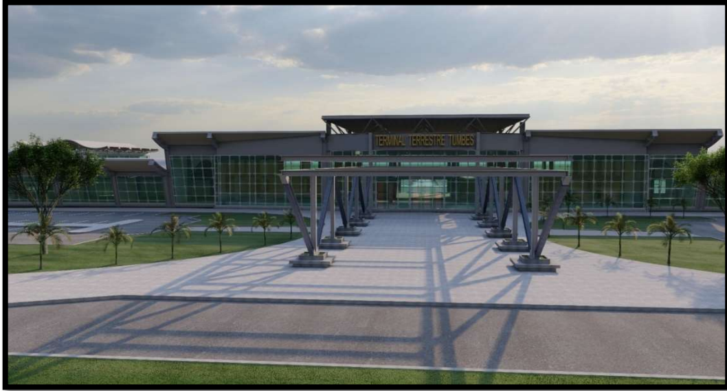
Figura 79. Vista Fachada Principal Terminal Terrestre Tumbes
