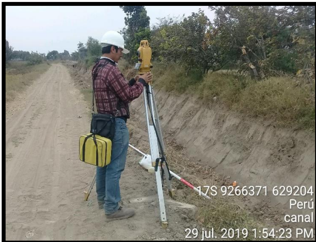
Figura 8: Instalación de la estación total para el levantamiento respectivo.
