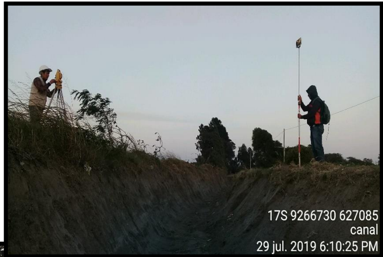
Figura 9: Instalación de la estación total para el levantamiento respectivo.
