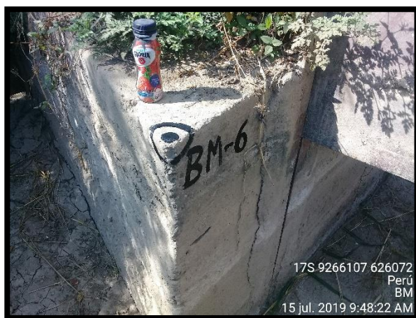
Figura 4: Se observa BM06, localizado en extremo de la estructura superior de compuerta.
