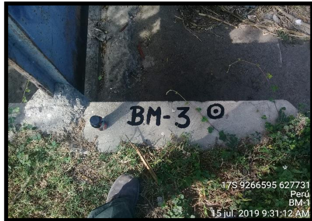
Figura 3: Se observa BM03, localizado en estructura superior de compuerta.
