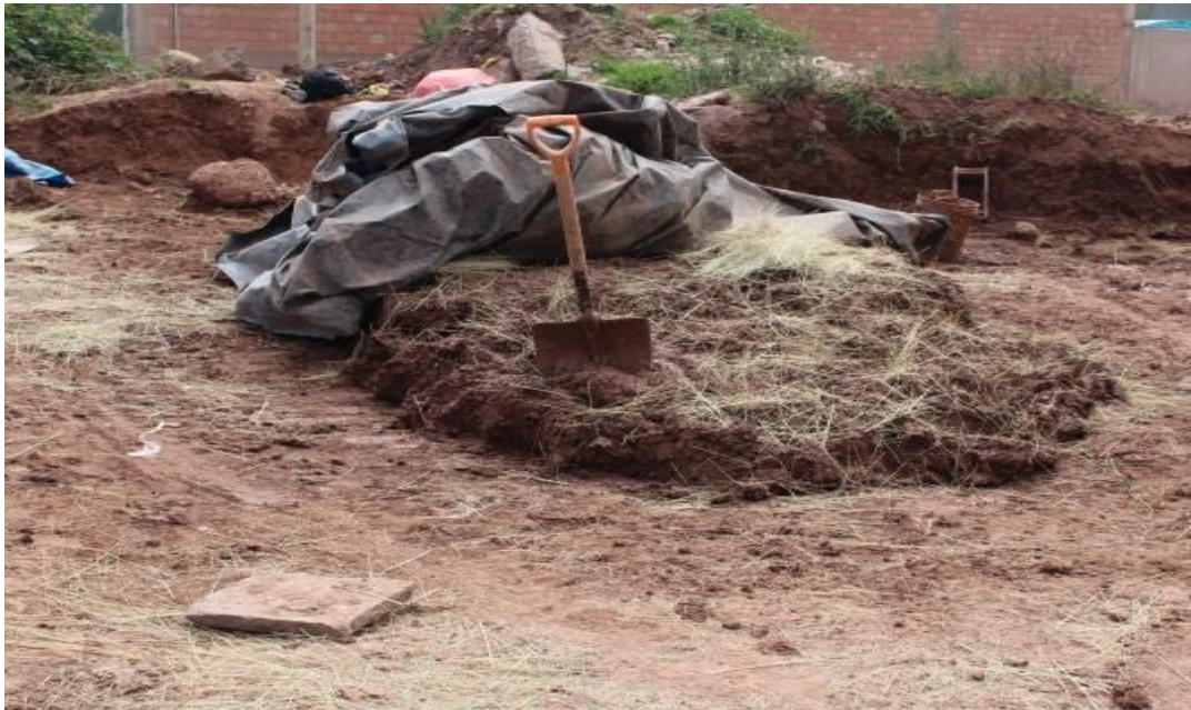
Figura 11. Mezcla de los materiales.
