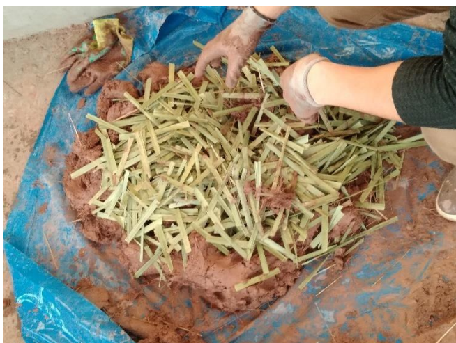
Figura 44 Mezclado de los insumos para la elaboración de los adobes
