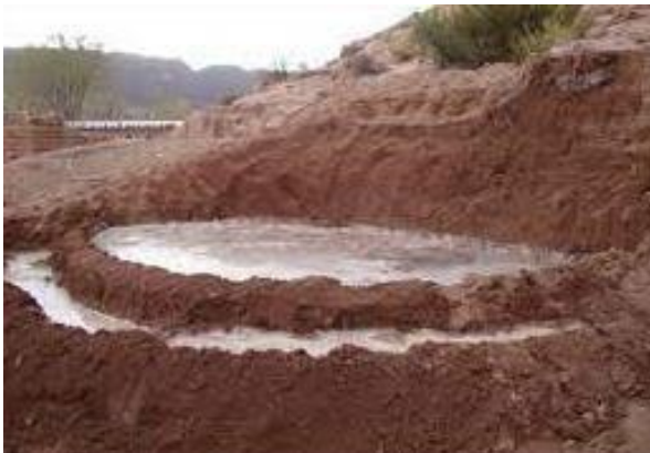
Figura 11 Suelo para adobe
