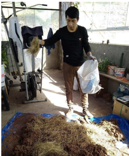
Figura 42 Integración de la paja al barro
