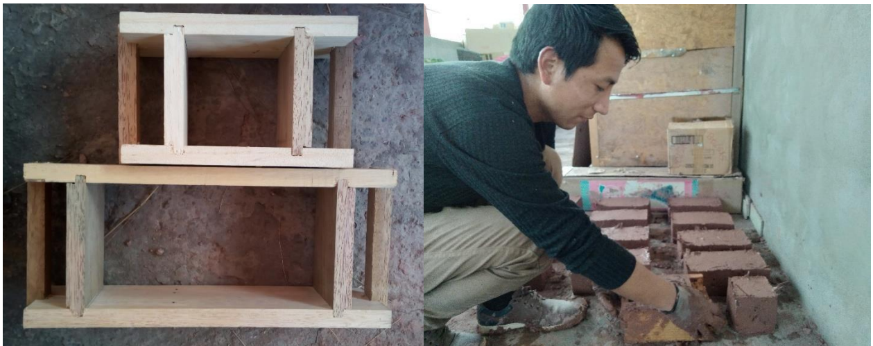
Figura 22. Conformación de los adobes.
