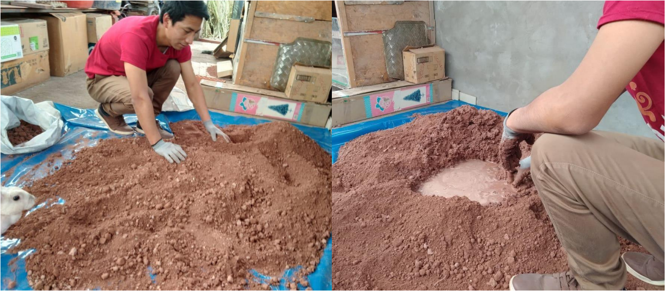
Figura 19. Preparación de la mezcla de barro.
