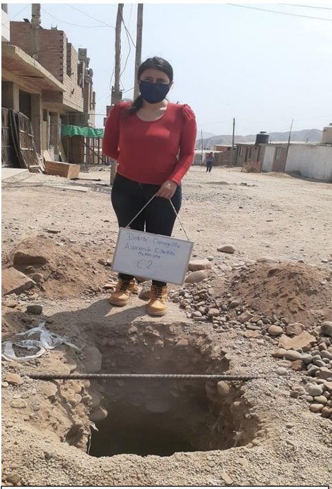
C-2: Excavación ya concluida
