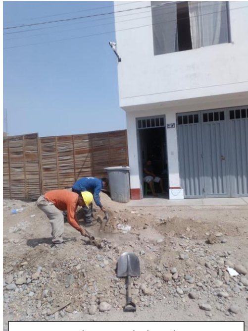
C-2: Clausura de la calicata.
