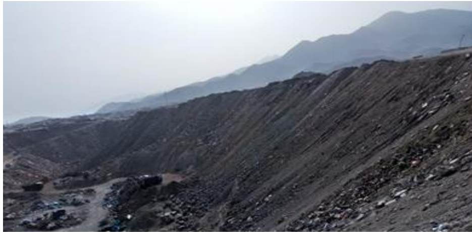
Figura 2: Evidencia de relleno de antrópico en la Asociación de Vivienda Estrellitas – Distrito Cieneguilla.
