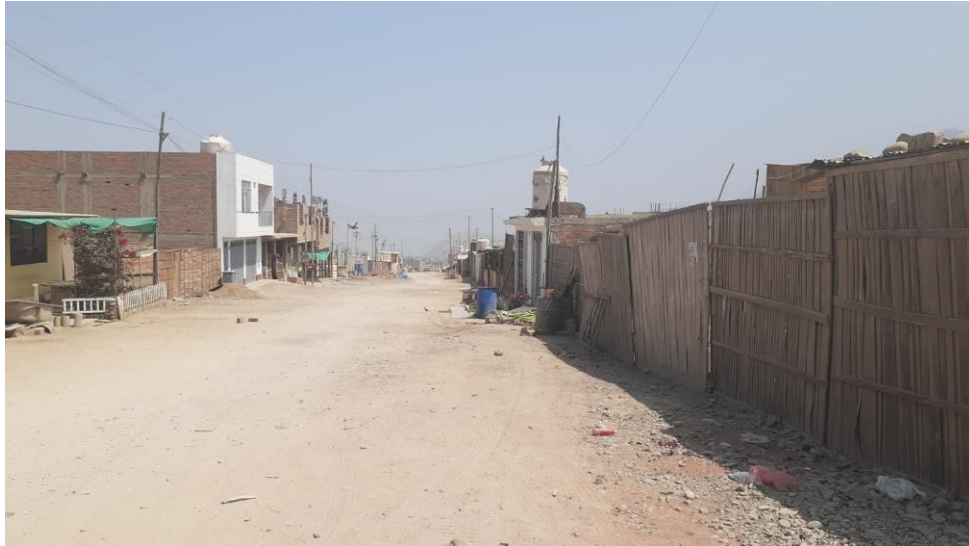
Figura 22: Construcción de viviendas sobre suelo de relleno – Asociación de viviendas Estrellita (Distrito de Cieneguilla).
