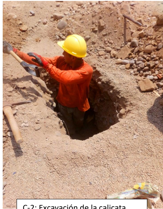
C-2: Excavación de la calicata
