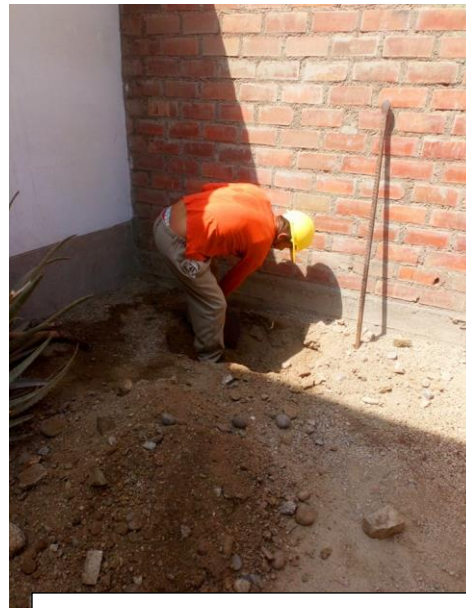
C-1: Excavación de la calicata
