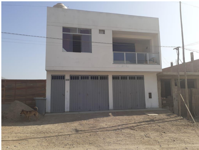
Figura 31: Vivienda de dos pisos sobre relleno Antrópico - Distrito Cieneguilla.
