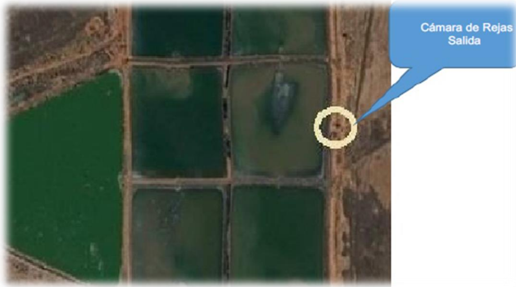
Figura 2.11 Cámara de Rejas Salida PTAR Juliaca Fuente: Diagnostico Situacional de la PTAR de Juliaca (google earth)
