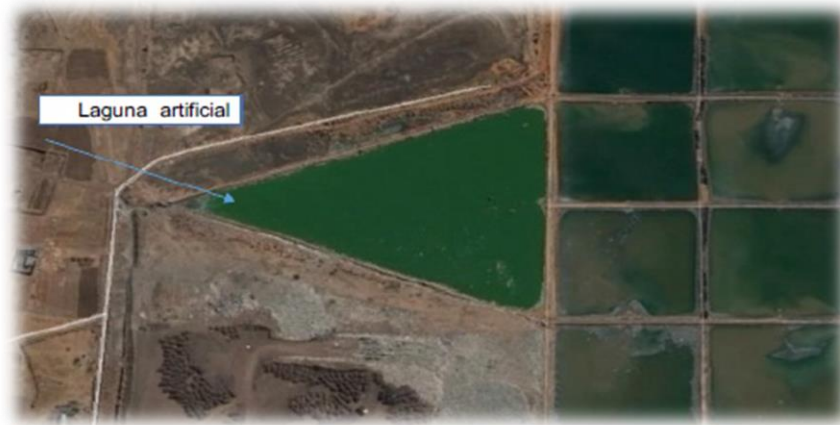
Figura 2.9 Laguna artificial PTAR Juliaca Fuente: Diagnostico Situacional de la PTAR de Juliaca (google earth)
