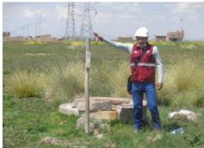
Figura 2.14 Buzones de Salida PTAR Juliaca Fuente: Diagnostico Situacional de la PTAR de Juliaca
