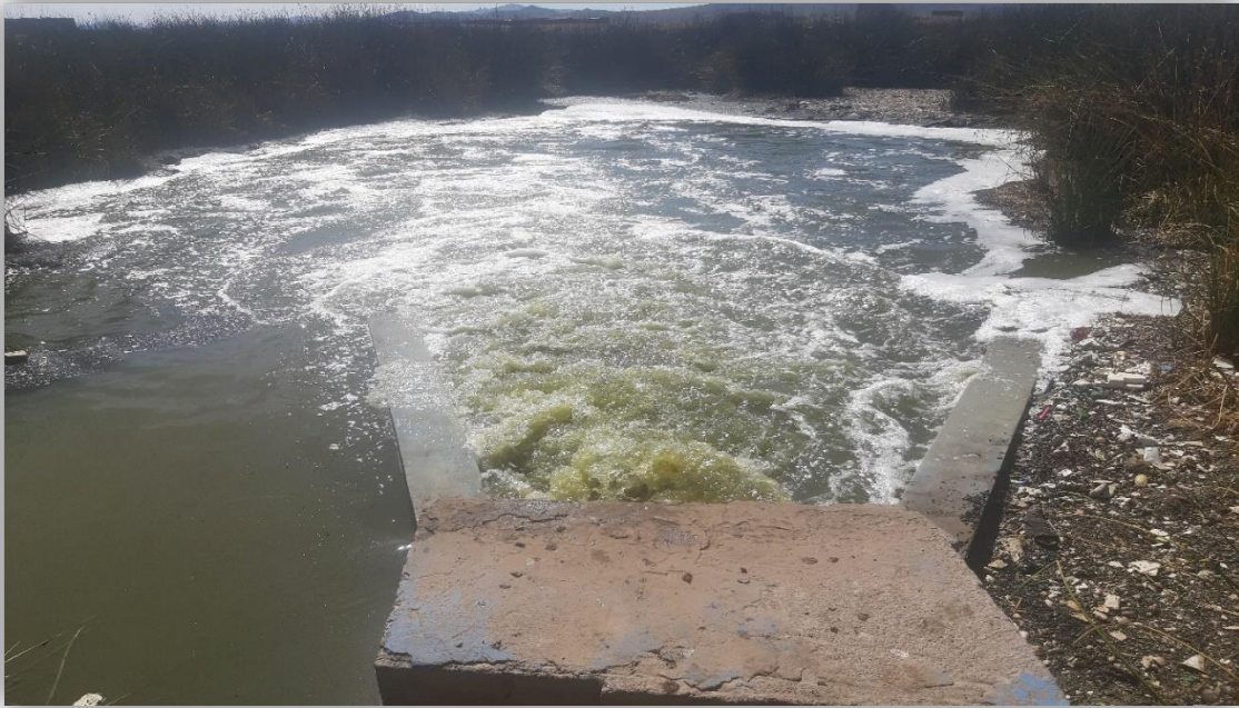
Efluente de la PTAR Juliaca, lugar donde se realizó los ensayos
