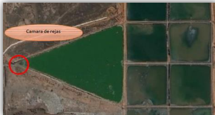
Figura 2.5 Cámara de rejas entrada PTAR Juliaca Fuente: Diagnostico Situacional de la PTAR de Juliaca (google earth)
