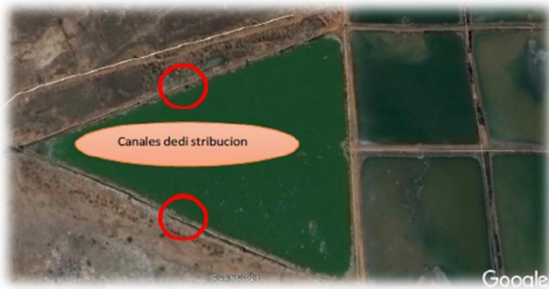
Figura 2.6 Canales de Distribución PTAR Juliaca
