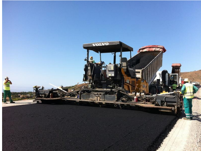
Figura 4. Mezclas asfálticas en frío y caliente
