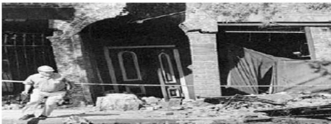
Figura N°5: Ejemplo de fallas por flexión
